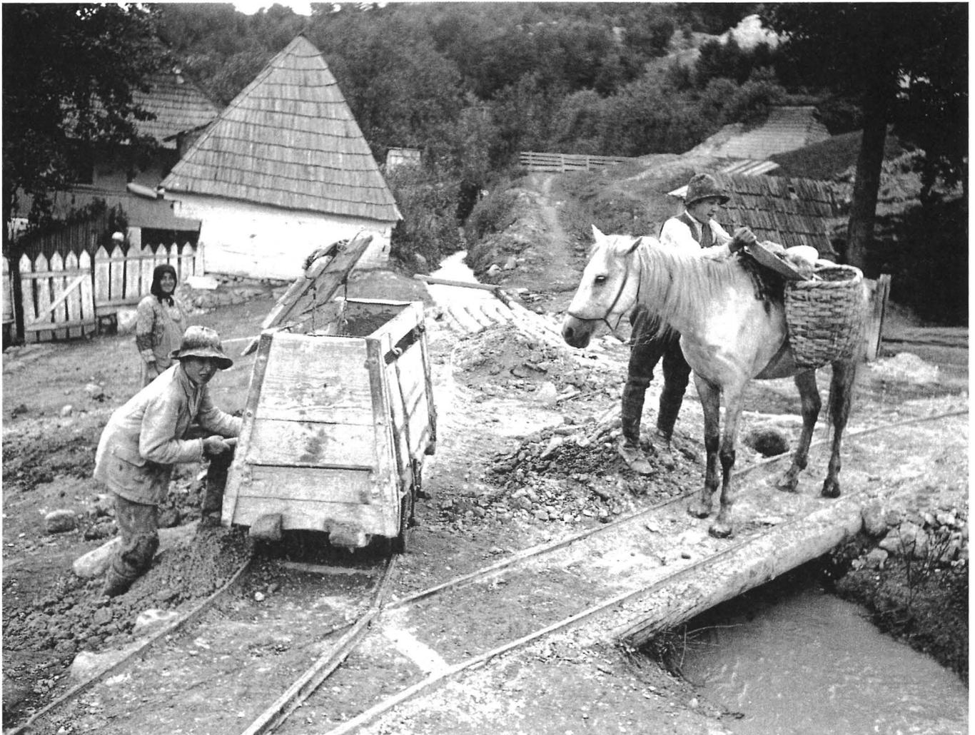
Abb. 13: Bergmann beim Entleeren eines hölzernen Förderwagens mit der Kratze, rechts ein Knappe mit Grubenpferd beim Füllen der geflochtenen Satteltaschen. Das Erzhaufwerk wird auf diese Weise zum Pochwerk transportiert
