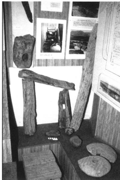
Abb. 70: Angren, mittelalterlicher Goldbergbau. Vor der Wand: Ausbauhölzer mit Zapfen und Zapfenlöchern, davor steinerne Schlägel und Mühlsteine der Aufbereitung (Museum Angren, Usbekistan, 1992)
