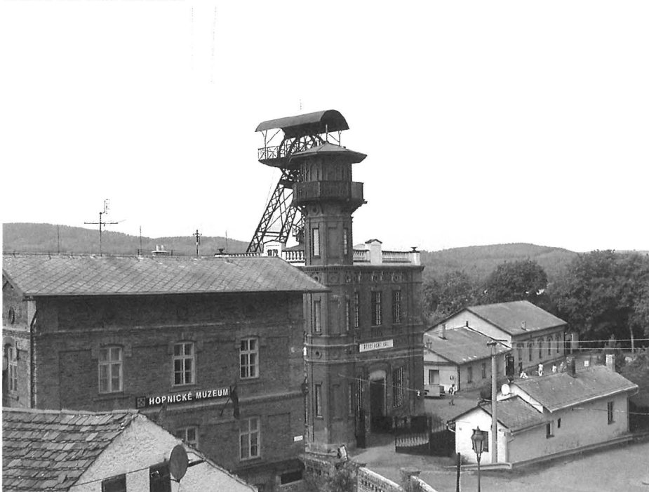
Abb. 2: Ševčín-Schacht (Kaiser-Franz-Josef-Schacht) im Stadtteil Březové Hory/Birkenberg von Příbram, Zentrum des größten Bergbaumuseums der Tschechischen Republik. Die Grube war von 1813 bis 1978 in Betrieb und erreichte eine Teufe von 1100 m
