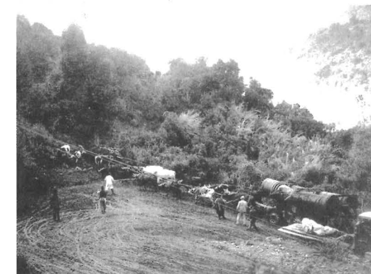
Sewell, Transport von Maschinen und Gerät (1921)
