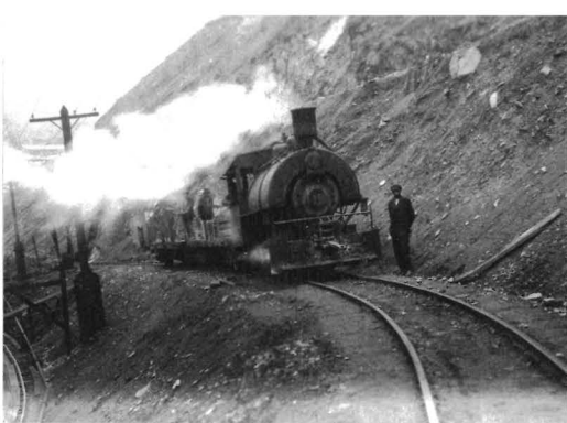
Sewell, Eisenbahn auf dem Weg nach Sewell
