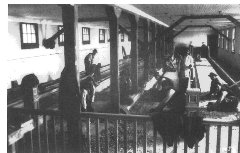
Sewell, Erbauung der Bowlingbahn
