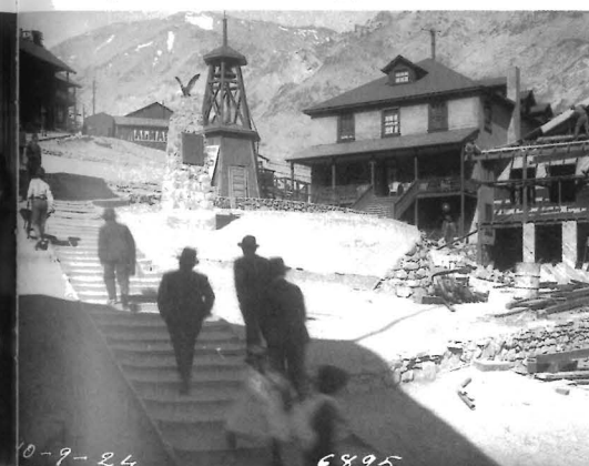
Sewell, O'Higgins-Platz an der zentralen Treppenanlage
