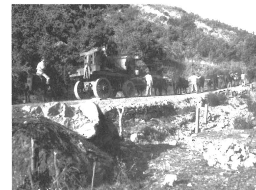
Sewell, Transport von Maschinen und Gerät (1919)
