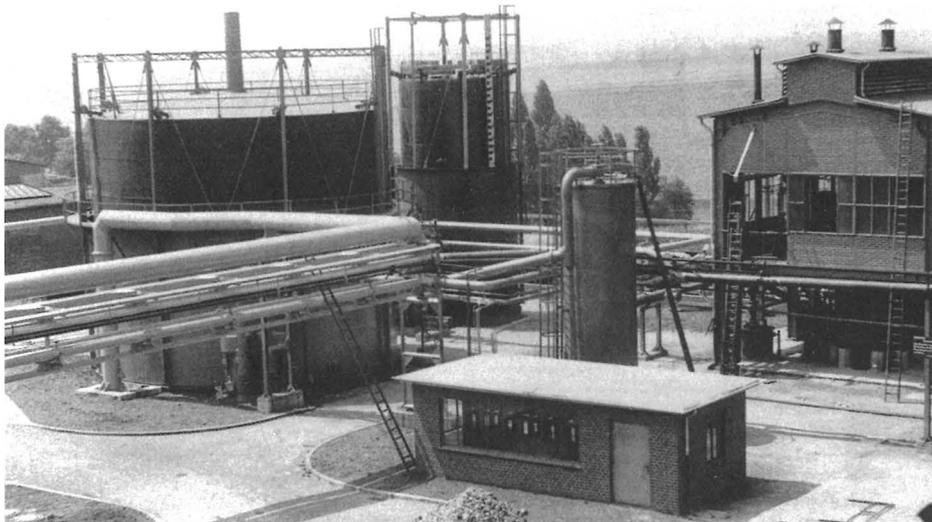
Abb. 29: Generatorenhaus und Gasometer für Wasserstoff und Kokereigas
