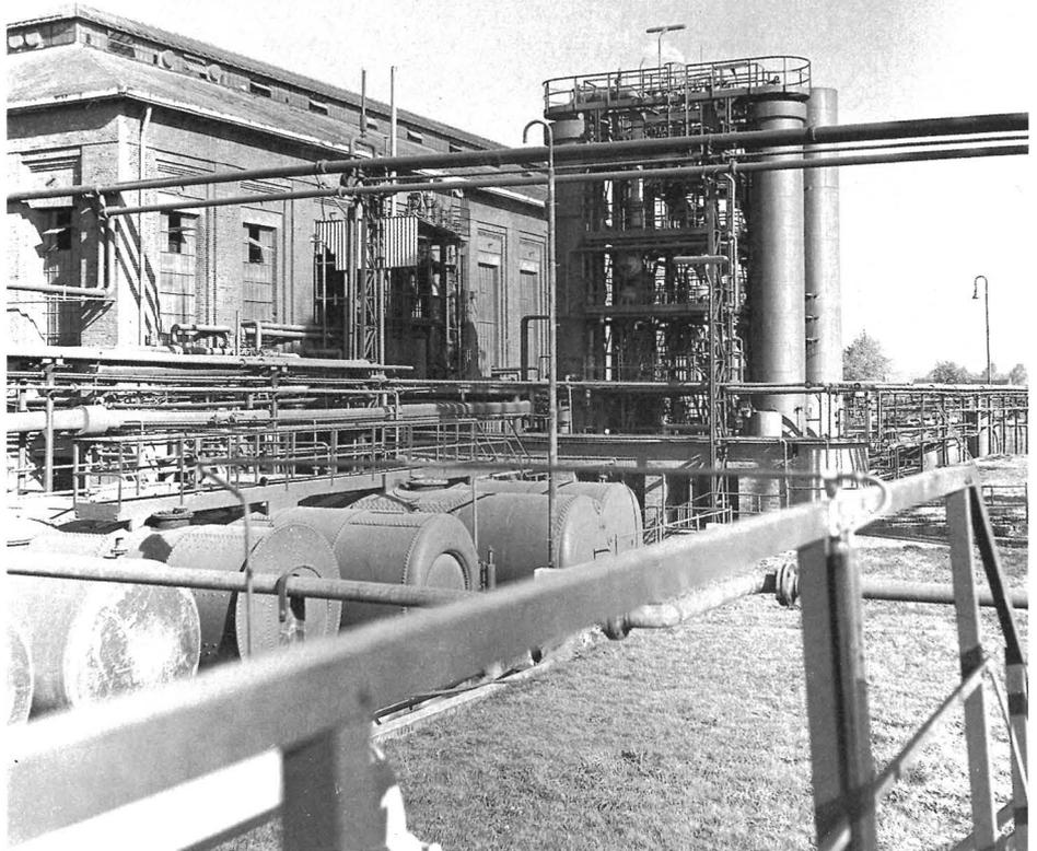
Abb. 34: Destillierkolonnen für Dodecylbenzol
