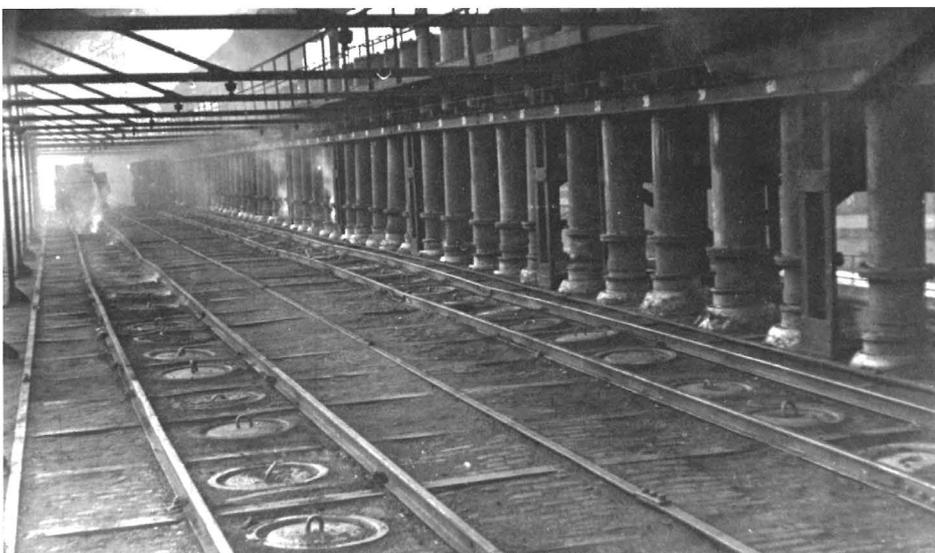
Abb. 10 a/b: Ofendecke der Abhitze-Batterie mit elektrisch angetriebenen Füllwagen
