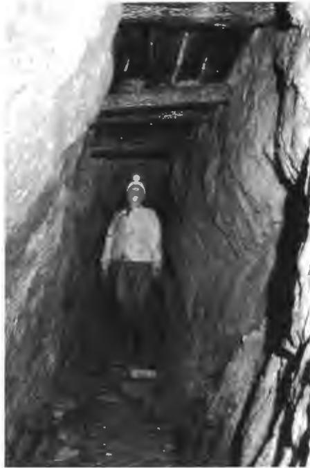
Abb. 13: Mit Eichenholz ausgebaute Grundstrecke unter den Firstenbauen der Eisensteingrube Vereinigung. Die Grube liegt in der Nachbarschaft des Bergbaumuseums des Landkreises Altenkirchen in Sassenroth bei Herdorf
