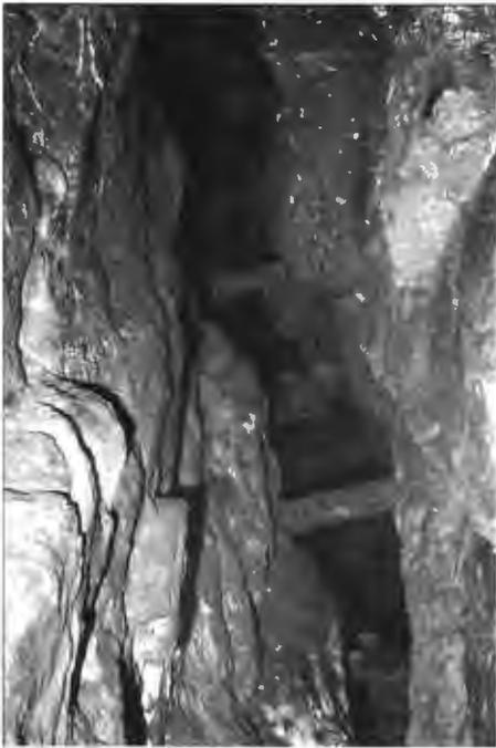
Abb. 12: Blick von oben in einen alten Strossenbau. Der Abbau erfolgte von oben nach unten. Auf dem waagrecht zwischen Hangendem und Liegendem des ausgeerzten Ganges eingebühten und noch in situ befindlichen Holzbalken lagen im Streichen des Ganges (heute verfaulte) Hölzer auf, die mit dem beim Tiefergehen im Gang entstehenden Abraum befüllt wurden. Diese so genannten Bergekästen sind heute zu Bruch gegangen
