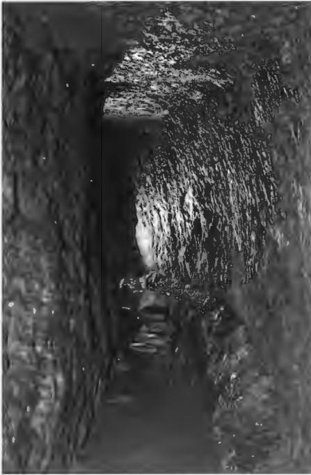
Abb. 18: Schlägel-und-Eisenarbeit in dem durchgehend ohne Schießarbeit aufgefahrenen Stollen der Grube Unteres Rimmelchen, unmittelbar nördlich der berühmten Spateisenzeche Guldenhard gelegen
