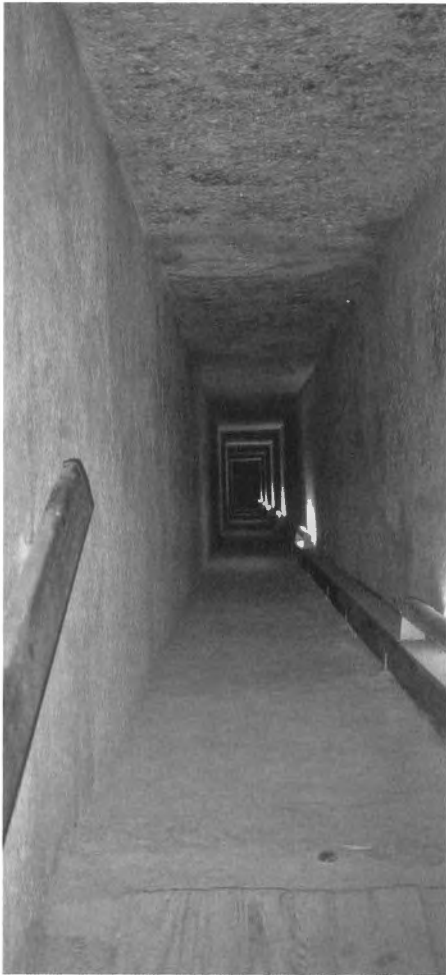
Abb. 4: „Tunnelblick“ – Auf 75 Ellen (Sollwert: 39,38 m, Istwert: 39,35 m) Länge ist der obere horizontale Korridor in Tunnelbauweise so exakt aufgeföhren worden, dass er in der Nord-Süd-Orientierung wohl nicht mehr als 1 cm abweicht
