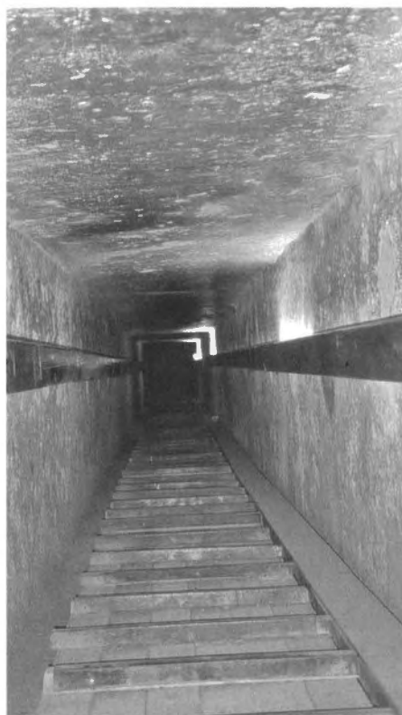
Abb. 3: Blick in den 34,15 m langen unteren schrägen, in Stollenbauweise vorgetriebenen Korridor der Chephren-Pyramide
