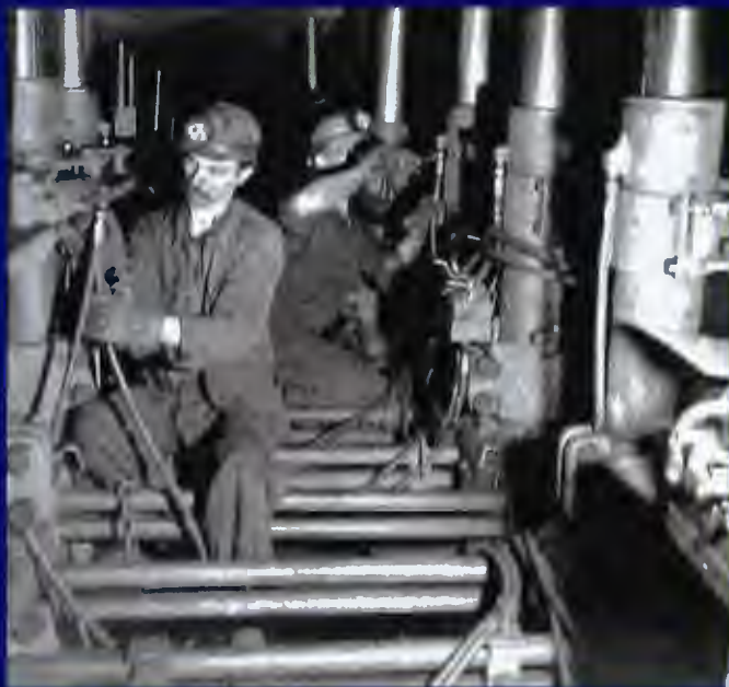
Abb. 30: Rücken von hydraulischen Stempeln. 1950er-Jahre (Lewarde, Centre Historique Minier) / Fig. 30: Pose d'un étauçon, années 1950. Centre Historique Minier
