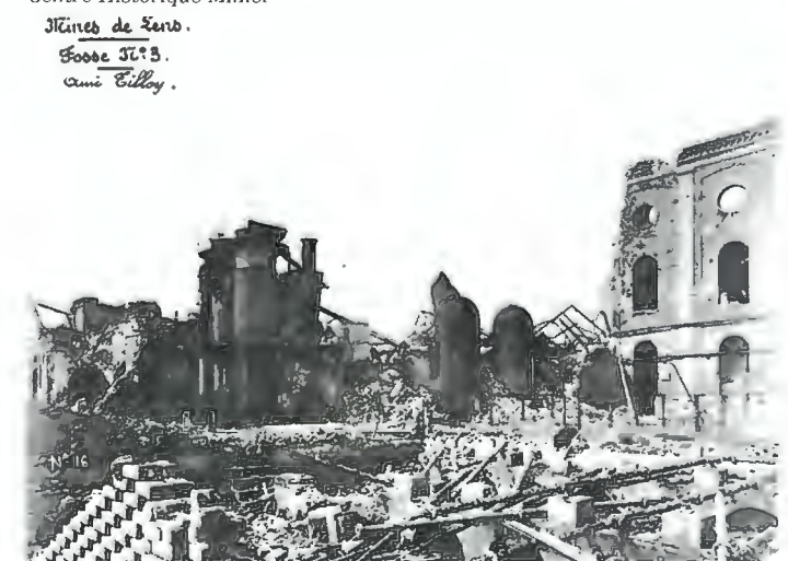
Abb. 16: Liévin, Zerstörung der Schachtanlage 3 („Amé-Tilloy“) der Compagnie des Mines de Lens, 1918 (Lewarde, Centre Historique Minier, Archiv) / Fig. 16: Destruction des mines de Lens, fosse 3 Amé-Tilloy, 1918. Archives du Centre Historique Minier
