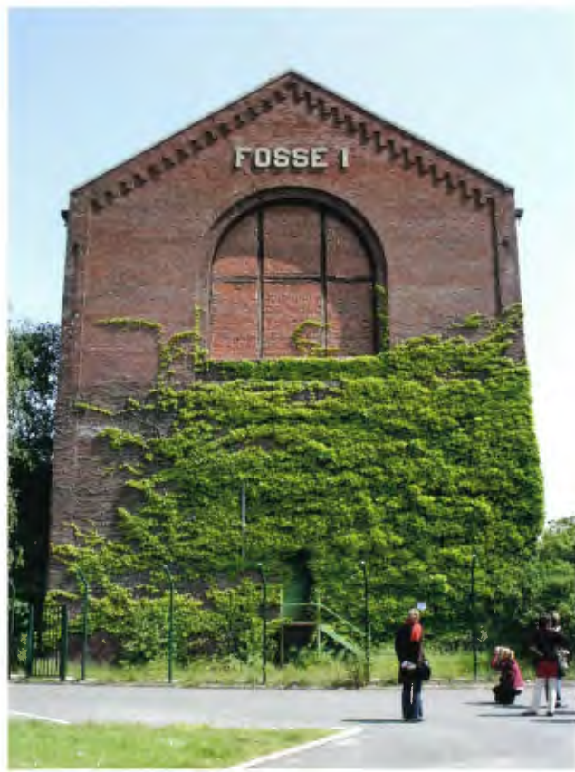
Abb. 6: Schachtanlage 1 der Compagnie des Mines de Noeux-Vicoigne-Drocourt / Fig. 6: Fosse n° 1 de la Compagnie des Mines de Noeux-Vicoigne-Drocourt à Noeux-les-Mines
