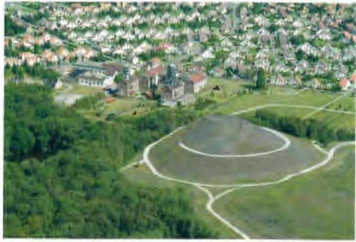
Abb. 3: Oignies, Schachtanlage 9/9a und Bergarbeitersiedlung Declercq / Fig. 3: Oignies, fosse 9/9bis et Cité Declercq
