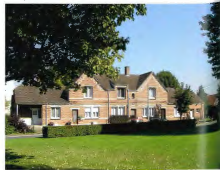
Abb. 37: Méricourt, Bergarbeitersiedlung „Résidence du Parc“ / Fig. 37: Méricourt, Résidence du Parc
