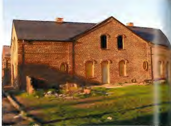
Abb. 30: Soutl, Bergarbeitersiedlung „Cité Soutl“ während der Sanierung / Fig. 30: Soutl, Cité Soutl pendant les rénovations
