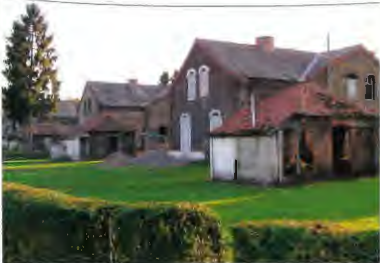
Abb. 29: Soutl, Bergarbeitersiedlung „Cité Soutl“ vor der Sanierung / Fig. 29: Soutl, Cité Soutl avant les rénovations
