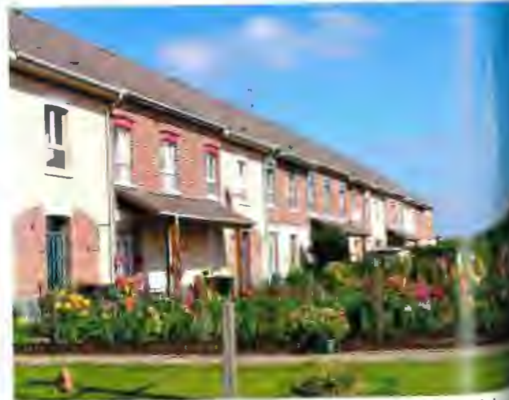
Abb. 91: Bully-les-Mines, Bergarbeitersiedlung „Corons d'Aix“ / Fig. 91: Bully-les-Mines, Corons d'Aix
