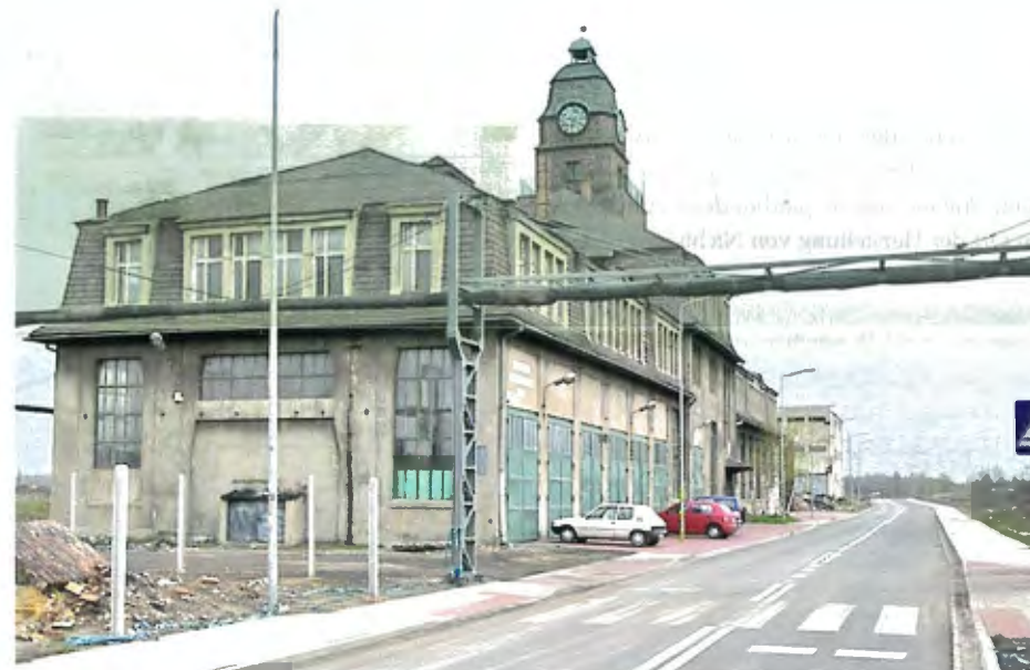
Abb. 3: Das ehemalige Verwaltungsgebäude im heutigen Zustand
