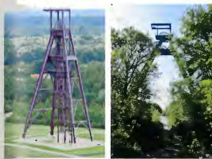
Abb. 10: Condé-sur-Escaut, Fördergerüst über dem Schacht Ledoux / Fig. 10: Chevalement de la fosse Ledoux à Condé-sur-Escaut, 1951 Abb. 11: Raismes, Fördergerüst über dem Schacht Sabatier / Fig. 11: Chevalement de la fosse Sabatier à Raismes, 1956
