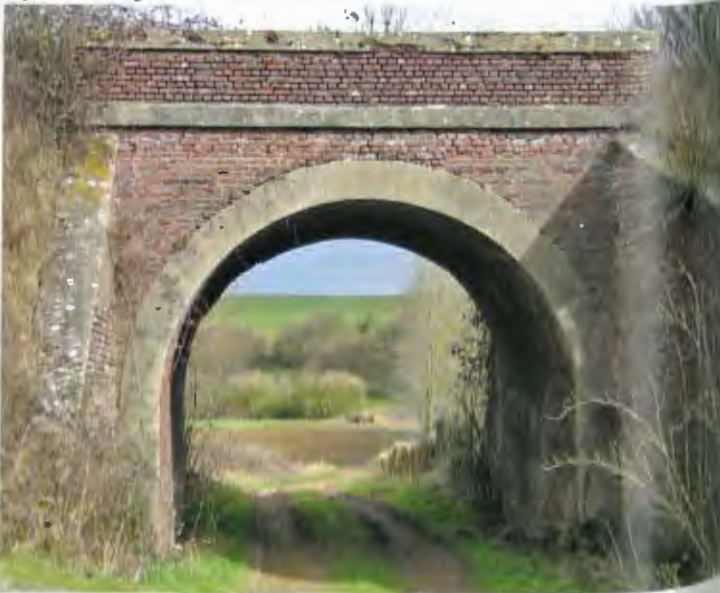
Abb. 25: Brückenbauwerk der ehemaligen Eisenbahnlinie Calonne-Ricouart / Fig. 25: Ouvrage d'art Calonne-Ricouart
