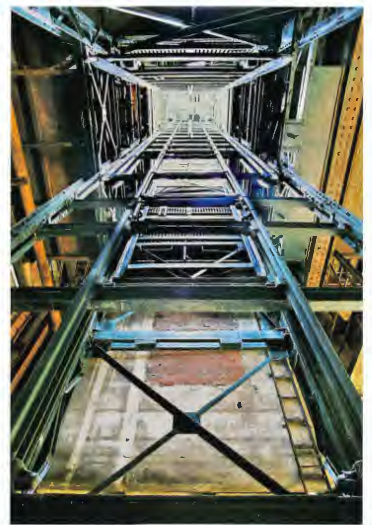
Abb. 13: Loos-en-Gohelle, Innenansicht des Förderturms über dem Schacht 19 / Fig. 13: Tour de la fosse n° 19 à Loos-en-Gohelle
