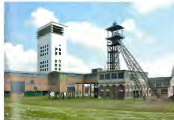
Abb. 3: Loos-en-Gohelle, Schachtanlage 11/19. Die Schachtanlage wurde noch kurz vor dem Beginn des Ersten Weltkrieges erneuert. In den 1950er-Jahren wurde sie eine Verbundanlage, die Erbauung des Förderturms war im Jahre 1958 abgeschlossen: über rechteckigem Grundriss errichtet, besitzt er eine Höhe von 66 m / Fig. 3: Fosse du 11/19 à Loos-en-Gohelle. Le site a été reconstruit au lendemain de la Première Guerre mondiale. Dans les années 1950, il a été transformé en siège de concentration, La construction de la tour a débuté en 1958: de base rectangulaire, sa hauteur est de 66 mètres
