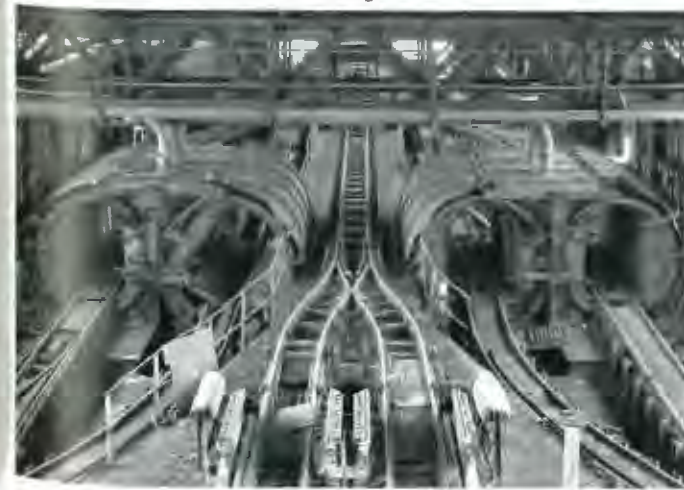
Abb. 4: Wallers, Wagenumlauf der Schachtanlage Wallers-Arenberg / Fig. 4: Salle des culbuteurs à Wallers-Arenberg
