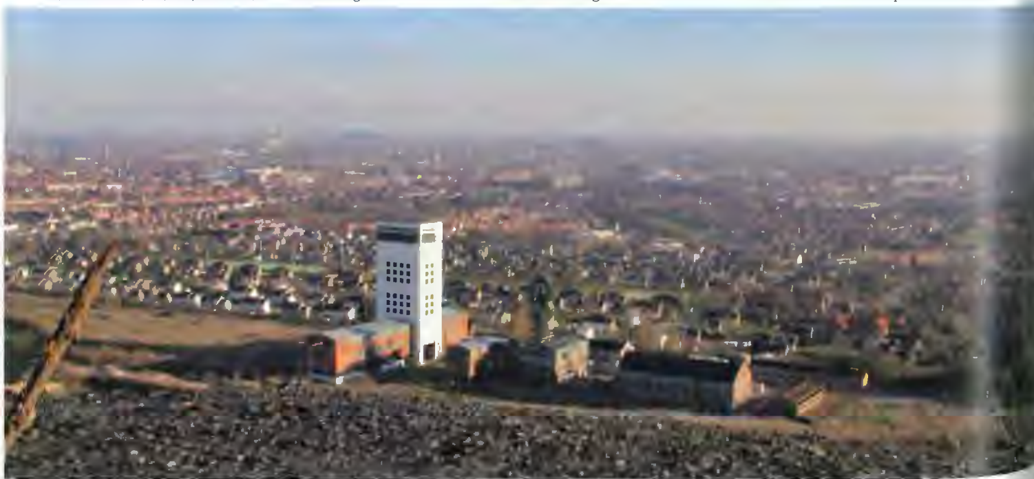
Abb. 40: Loos-en-Gohelle. Blick über die Schachtanlage 11/19 von einer der beiden Halden / Fig. 40: Vue sur le site du 11/19 de Loos-en-Gohelle depuis un des terrils
