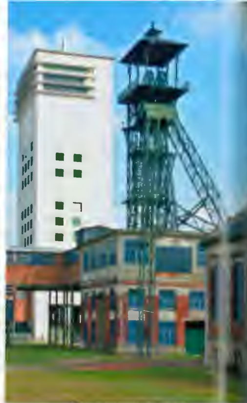
Abb. 50-54: Loos-en-Gohelle. Schachtanlage 11/19 Fig. 50-54: Site du 11/19 à Loos-en-Gohelle
