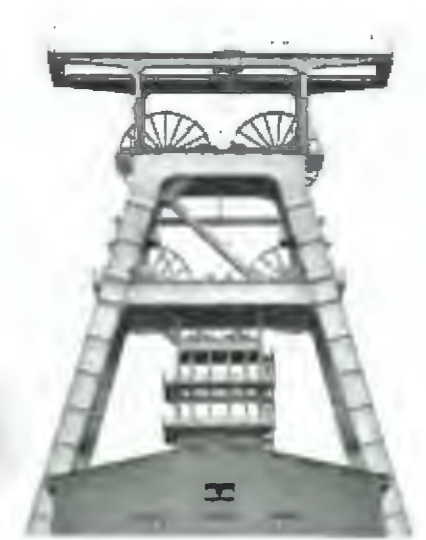
Abb. 44: Wallers, Fördergerüst der Schachtanlage Wallers-Arenberg / Fig. 44: Chevalement à Wallers-Arenberg
