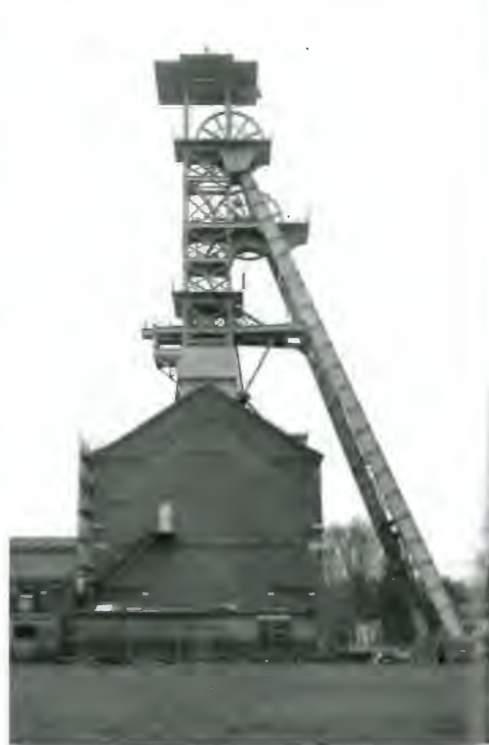
Abb. 43: Wallers, Fördergerüst der Schachtanlage Wallers-Arenberg / Fig. 43: Chevalement à Wallers-Arenberg
