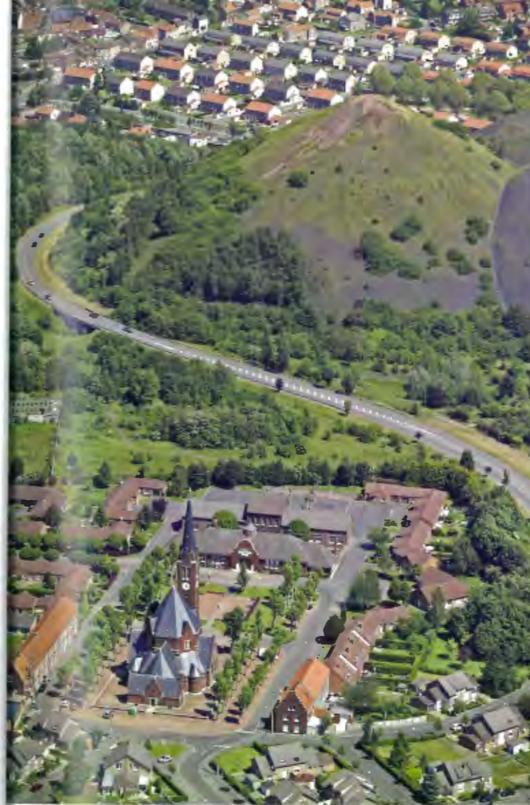
Abb. 5: Rouvroy, Kirche, Bergschule und Halde / Fig. 5: Église et école minières et terril à Rouvroy
