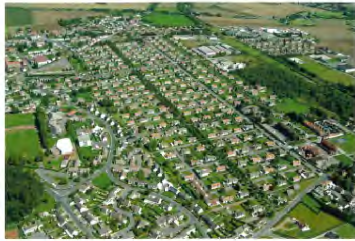
Abb. 7: Loos-en-Gohelle, Bergarbeitersiedlung mit Einfamilienhäusern am Schacht 10 / Fig. 7: Cité pavillonnaire de la fosse 10 à Loos-en-Gohelle
