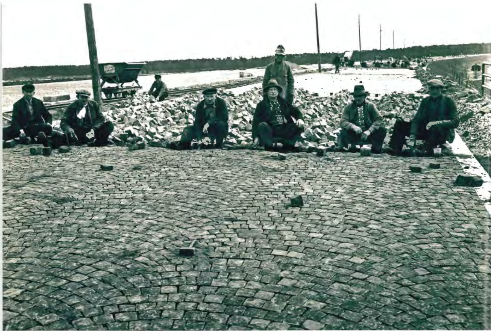
Abb. 5: Bau einer Pflastersteinstraße
