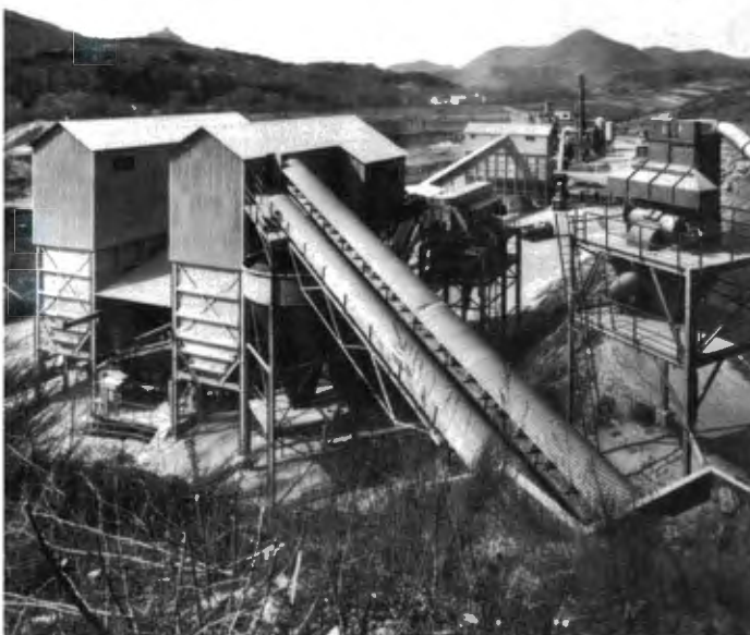
Abb. 6: Aufbereitungsanlage in den 1960er-Jahren
