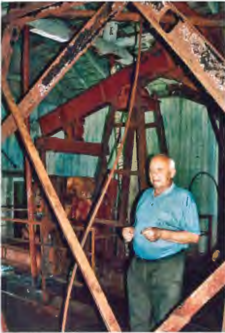
Abb. 1: Pumpenhaus der Saline Drohobytsch
