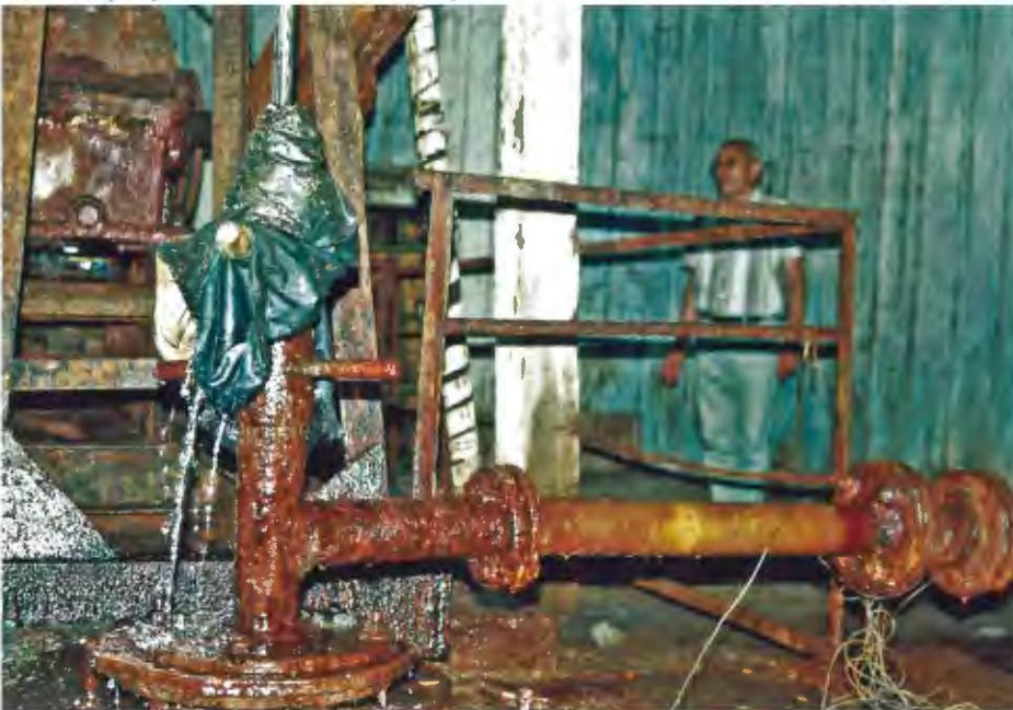
Abb. 2: Solepumpe von 1902 in der Saline Drohobytsch
