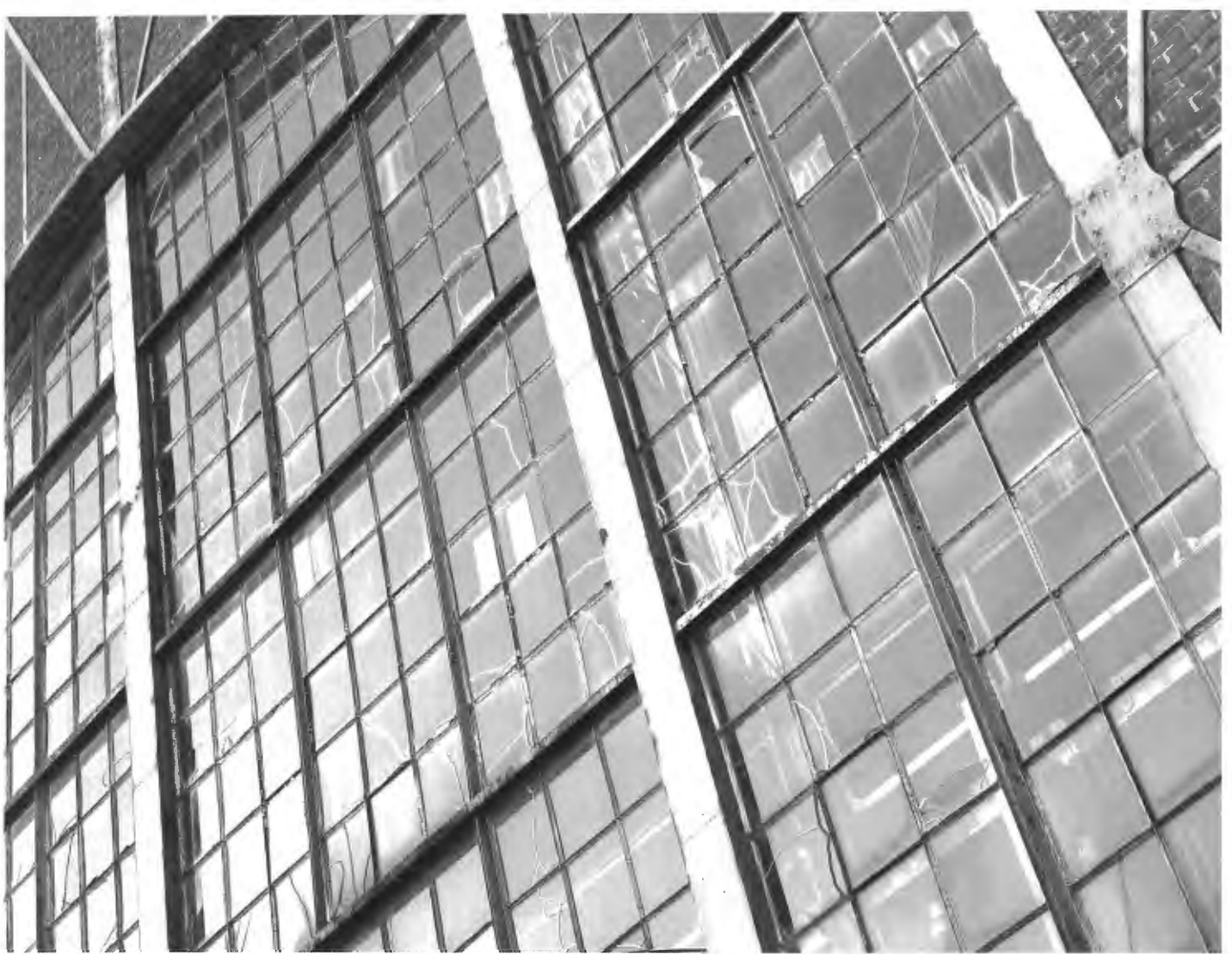
Abb. 7: Südfassade der Maschinenhalle, Zeche Zollern, Dortmund 2007, 135 cm x 116 cm
