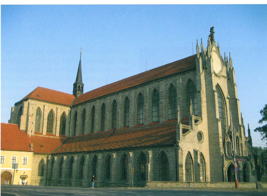
Abb. 2: Von Mönchen aus Waldsassen gegründetes Kloster in Sedletz/Sedlec. Die zerstörte Kirche wurde in der Barockzeit im gotischen Stil aufgebaut und ist nach der Innenrenovierung seit 2009 wieder zugänglich
