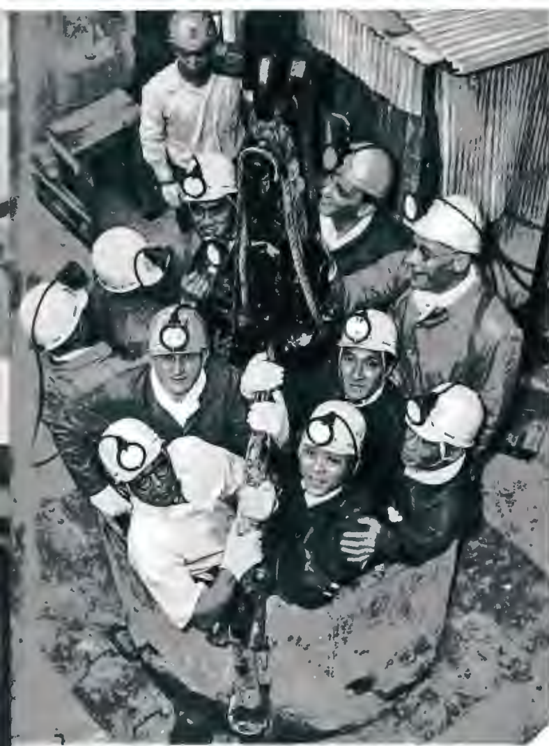
Abb. 9: Anfahrt beim Abteufen eines Außenschachtes der Grube Sunagawa, Hokkaido
