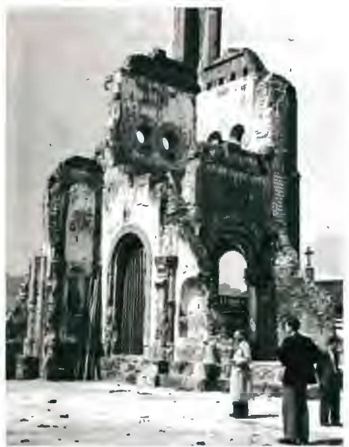
Abb. 18: Zerstörte Kirche in Nagasaki, Kyushu
