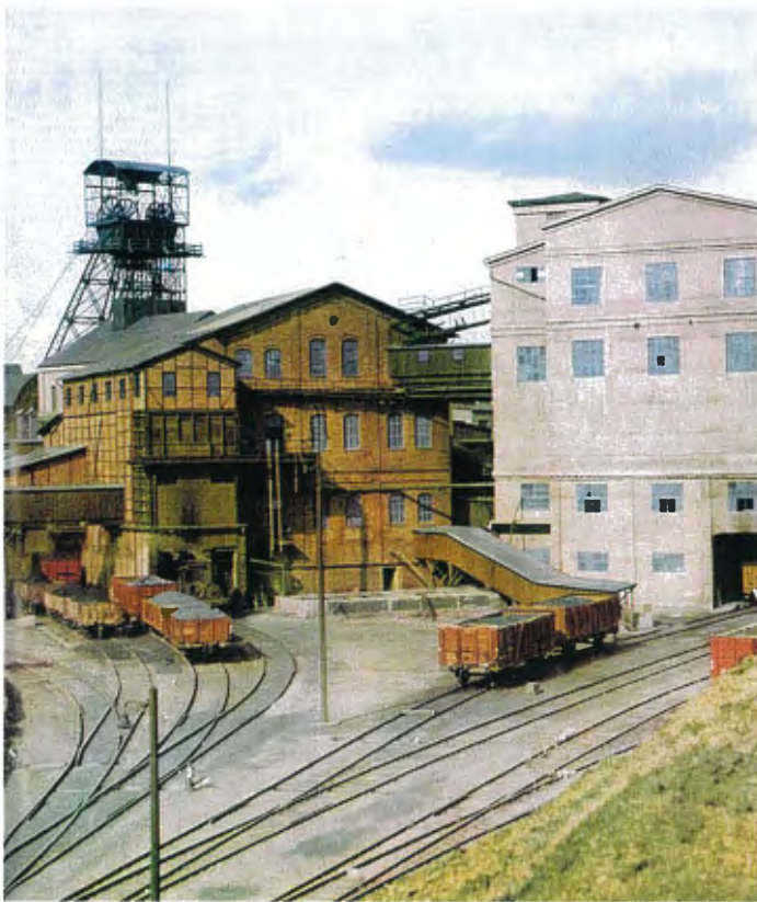
Schacht I des Zwickauer VEB Steinkohlenbergwerks Karl Marx auf dem Brückenberg (um 1955). Der von 1859-1865 niedergebrachte ‚Einigkeitsschacht‘ hatte eine Tiefe von 304 Metern und diente von 1867 bis zur Schachtverwahrung 1969 dem Förderbetrieb. Der markante Stahlförderturm wurde im Jahr 1910 errichtet (Aufnahme um 1955)
