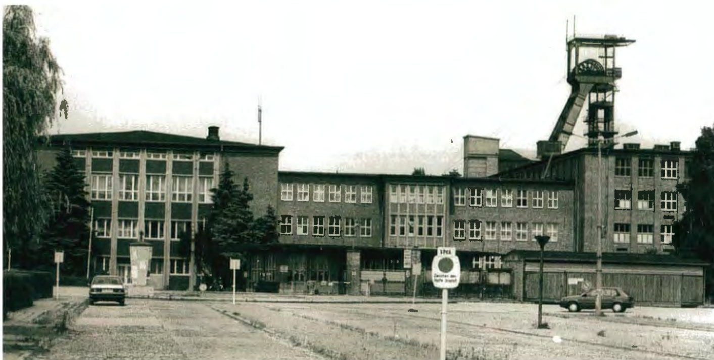
Bernard-Koenen-Schacht 1 in Niederröbblingen 1989. Teufbeginn 1952, Endteufe 692 m, Produktionszeit 1958-1990
