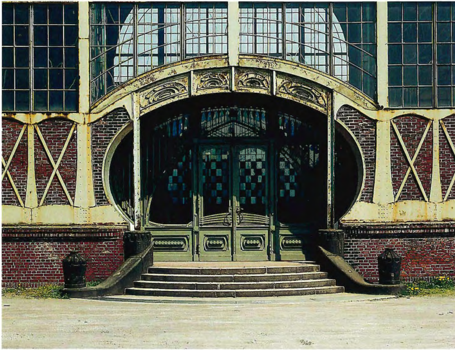
Die Maschinenhalle der Zeche Zollern II/IV
