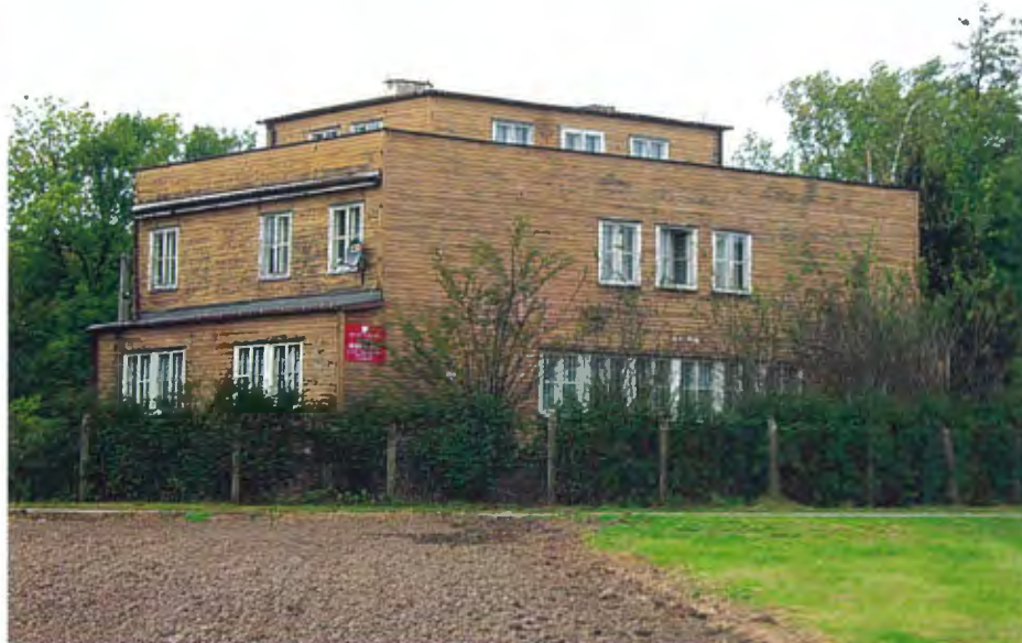
Abb. 1: Das Gebäude des Geophysikalischen Observatoriums in Racibórz nach dem Projekt des Architekten Konrad Wachsmann
