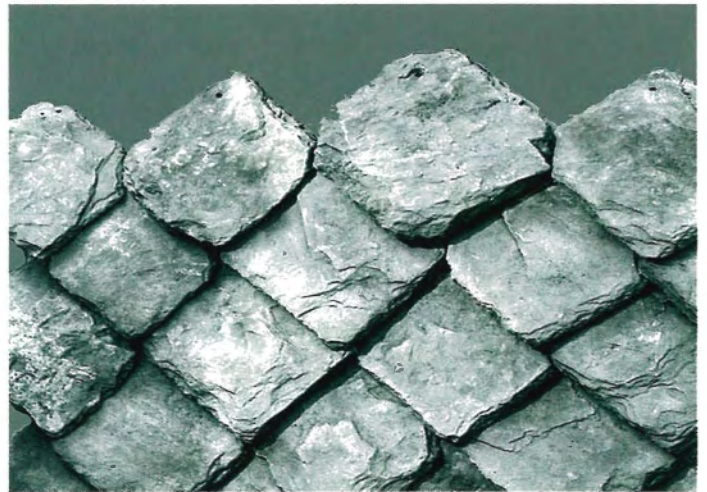
Abb. 3: Eine aus zufälligen Original-Funden zusammen gestellte Sechseckdeckung im Landesmuseum Trier. In der oberen Decksteinreihe sind deutlich die aus der Mittellinie nach links versetzten Nagellöcher zu erkennen. Bei der Rekonstruktion ist die Überdeckung nicht ganz korrekt eingehalten (korrekt vgl. Abb. 2) (Zustand ca. 2003).
