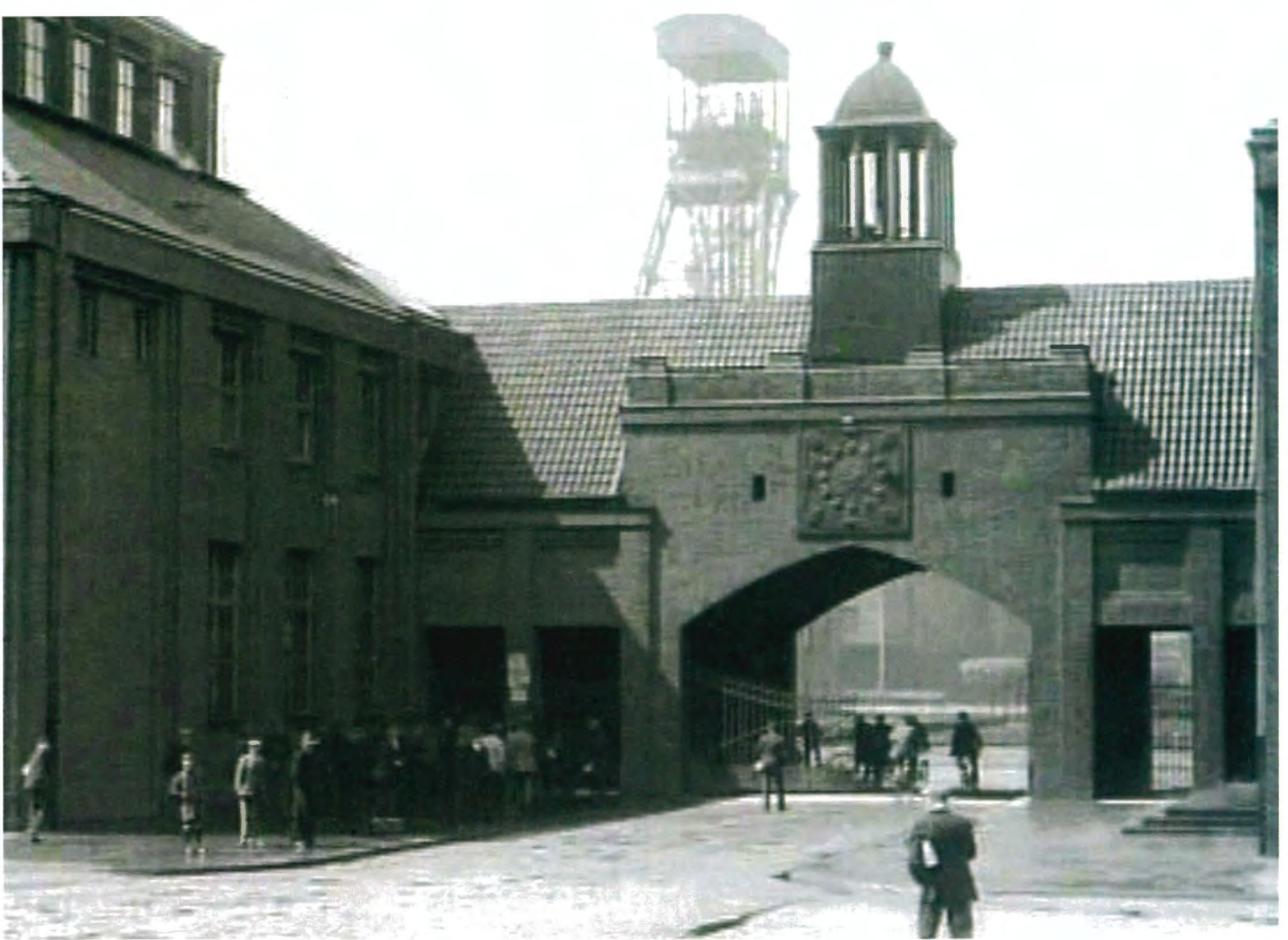
Abb. 4: Zechentor des Steinkohlenbergwerks Jacobi 1/2 in Oberhausen in „Die Ruhrkohle“ (Deutschland 1928)
