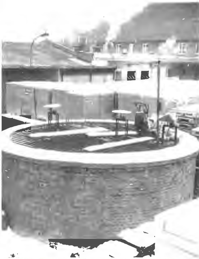
Abb. 19: Schachtkopfsicherung Conow mit akustischen Warnanlagen
