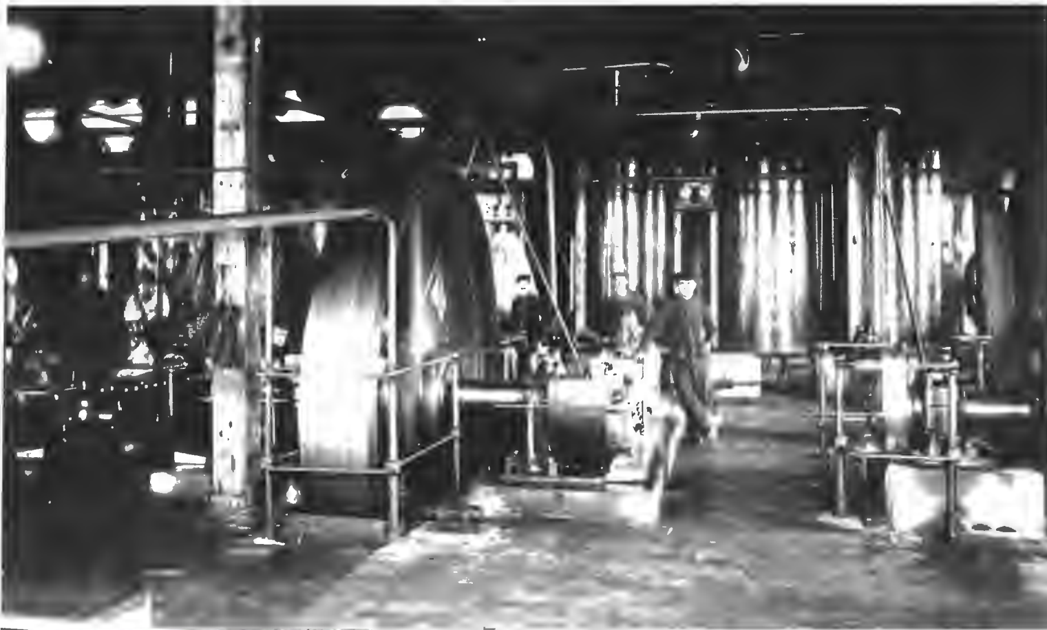
Abb. 17: Gefriermaschinenraum auf Schacht Conow
