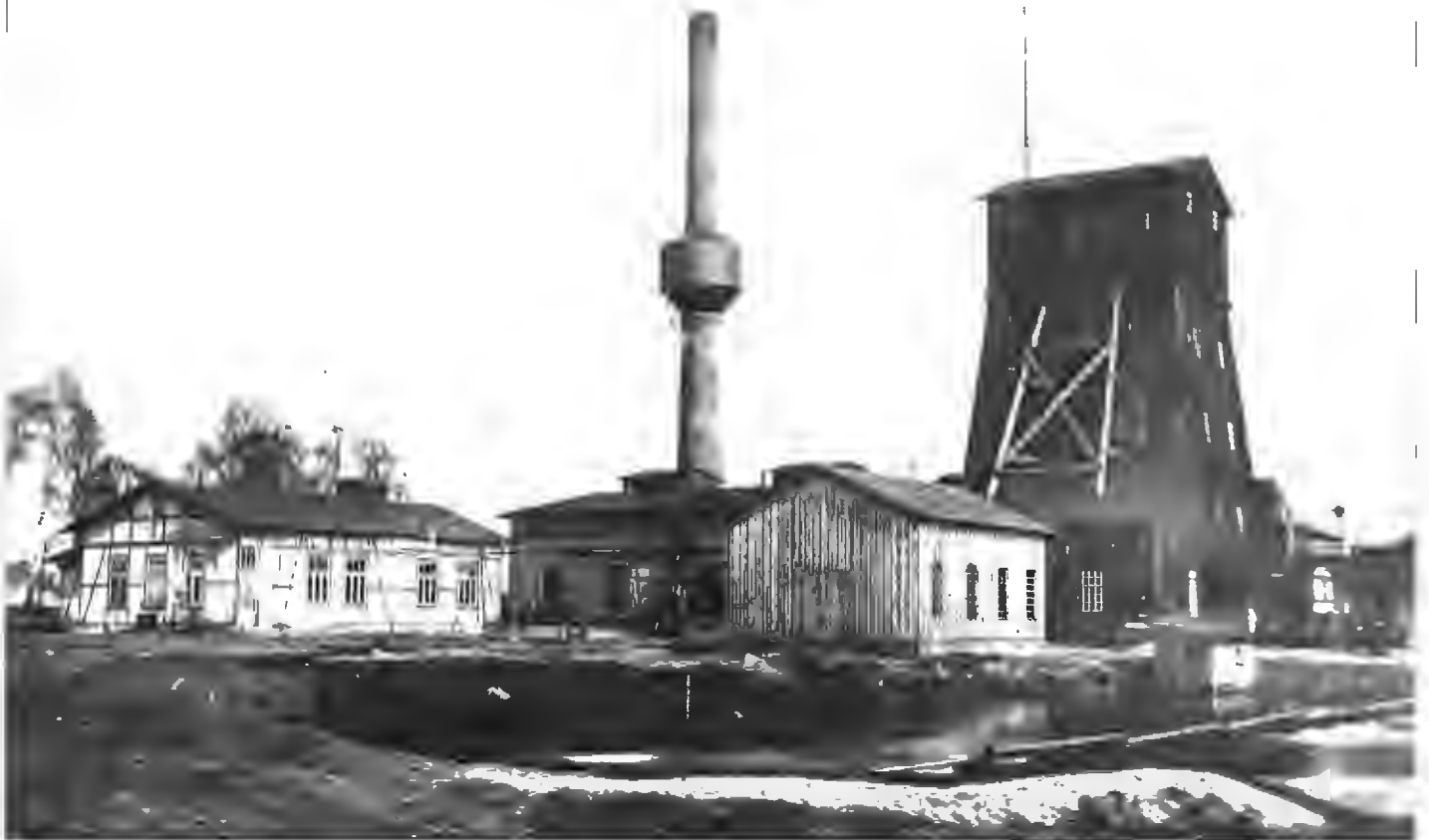
Abb. 16: Hölzerner Abteufurm im Jahre 1912
