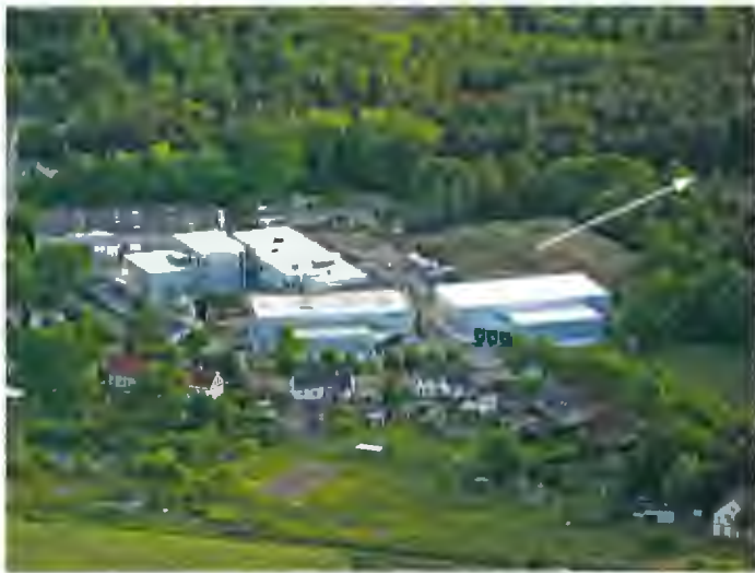
Abb. 8: Nachnutzung des einstigen Schachtareals durch die Rudolf Dankwardt GmbH; rechts oben der Alt-Kalischacht Jessenitz
