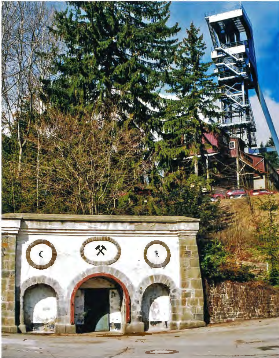
Mundloch des Achenbachschachts (1907). Im Hintergrund das neue Fördergerüst des Bergwerks Hilfe Gottes von 1976 mit Vollwandstreben aus Kastenprofilen
