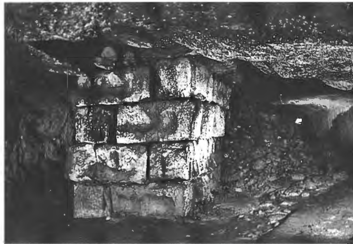
Abb. 3a: Três Minas. Galeria do Pilar. 24 Pochsohlen bilden die Ummantelung des Pfeilers
