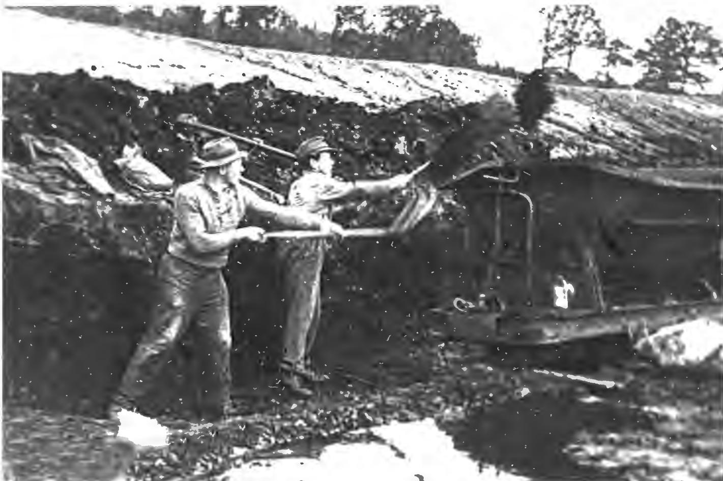
Abb. 10: Beladen der Kipploren im Tagebau A (1946)
