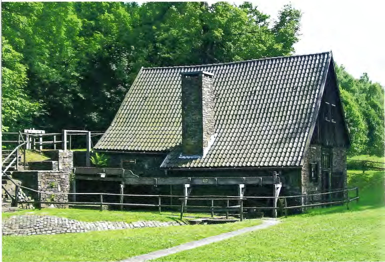
Das Hammerwerk der Wendener Hütte, in dem sich zunächst ein Eisenfrischhammer befand. Das Roheisen des Hochofens war nicht schmiedbar, so dass es zunächst zu Schmiedeeisen gefrischt und zu Stabeisen geformt werden musste, was im Hammerwerk geschah. Im Jahr 1774 wurde in dem Gebäude ein Raffinierhammer eingebaut, der der weiteren Veredelung des Schmiedeeisens diente.
