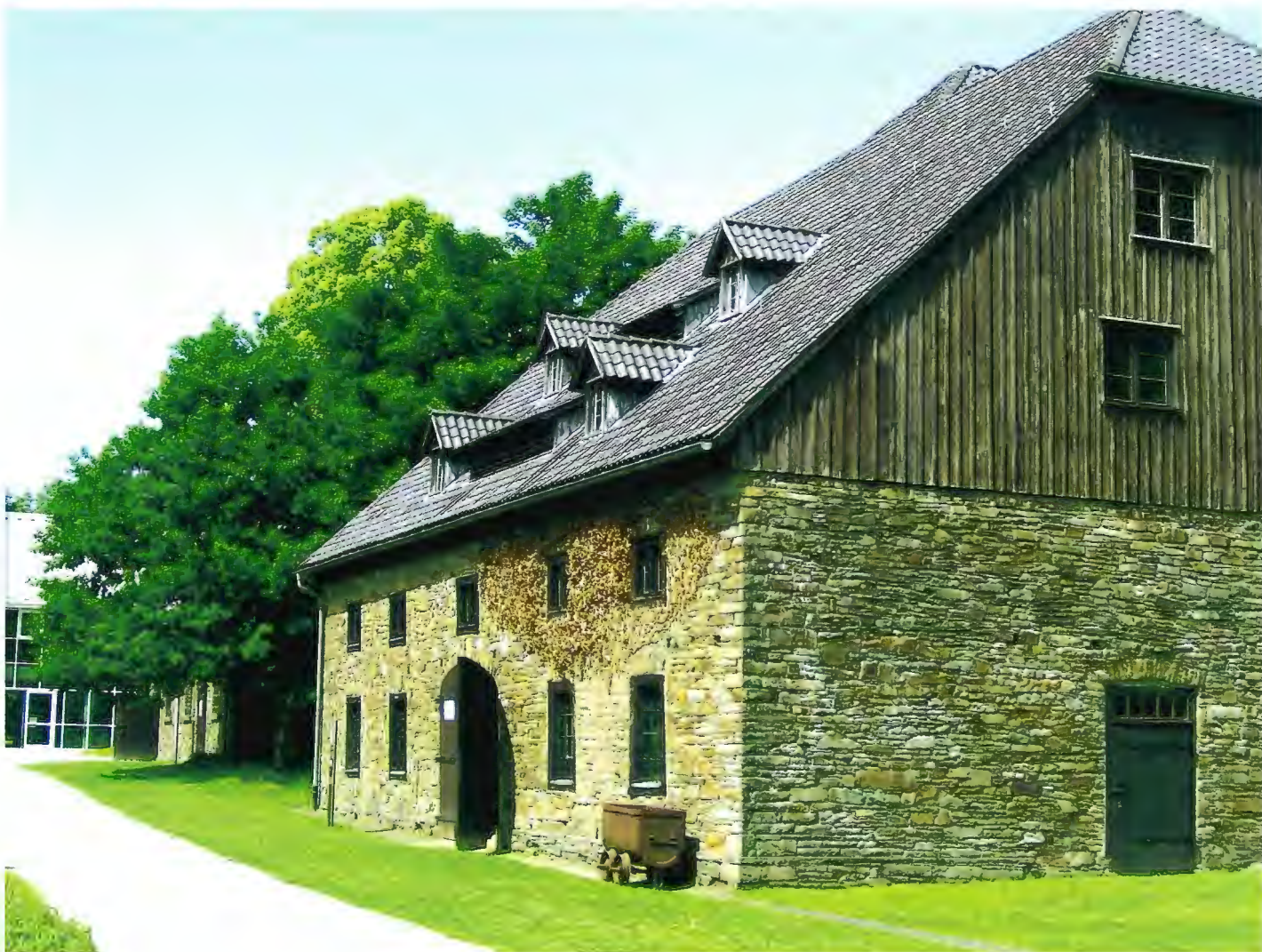
Die Gießhalle der Wendener Hütte mit Hochofen und Wasser getriebenem Hochofengebläse im Inneren. Die Gießhalle stellt das zentrale Gebäude des Hüttenwerkes dar.
