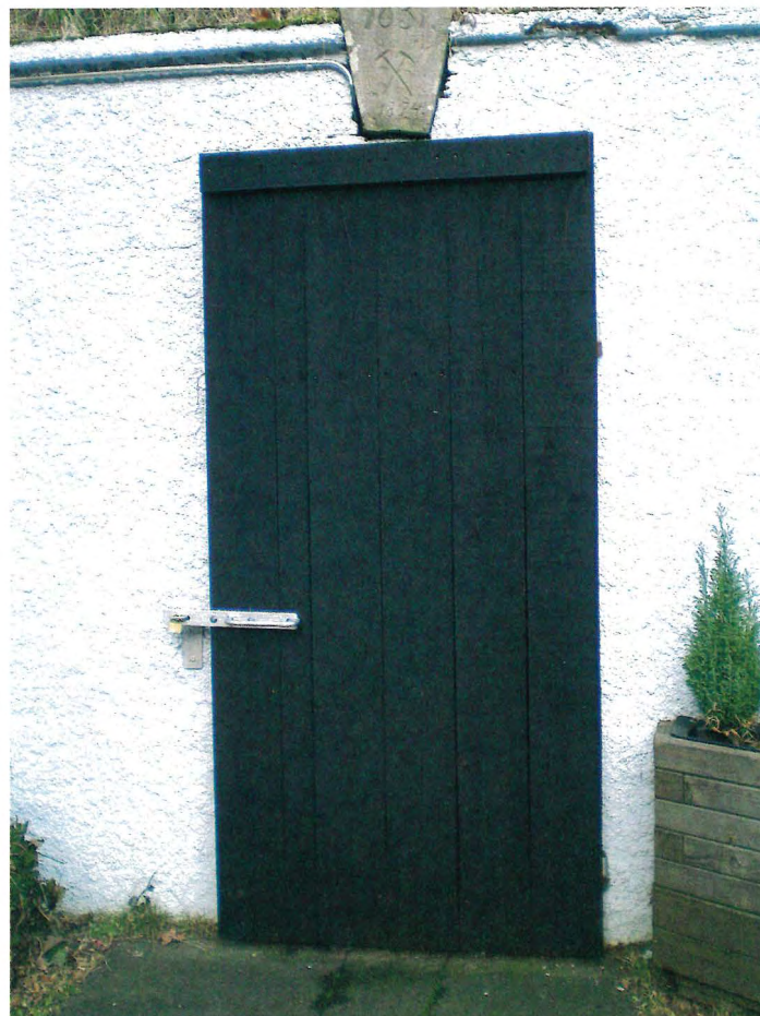
Der Eingangsbereich des Tiefen Stollens der Grube Guldenhardt heute.
