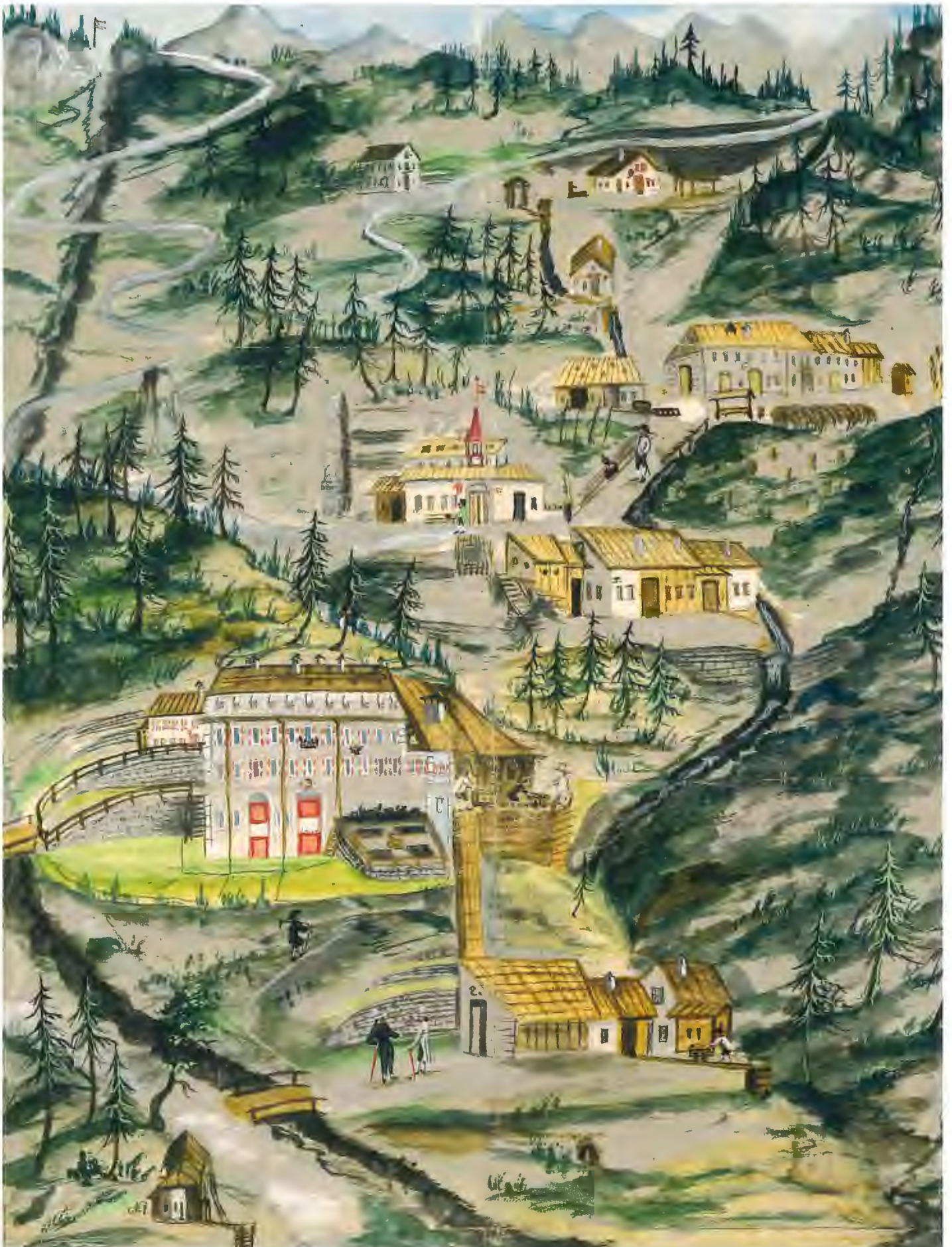
Abb. 3: Das Salzbergwerk im Halltal mit einzelnen Stollenanlagen und dem Herrenhaus für die Verwaltung und als Nachtquartier für die Arbeiter, um 1780
