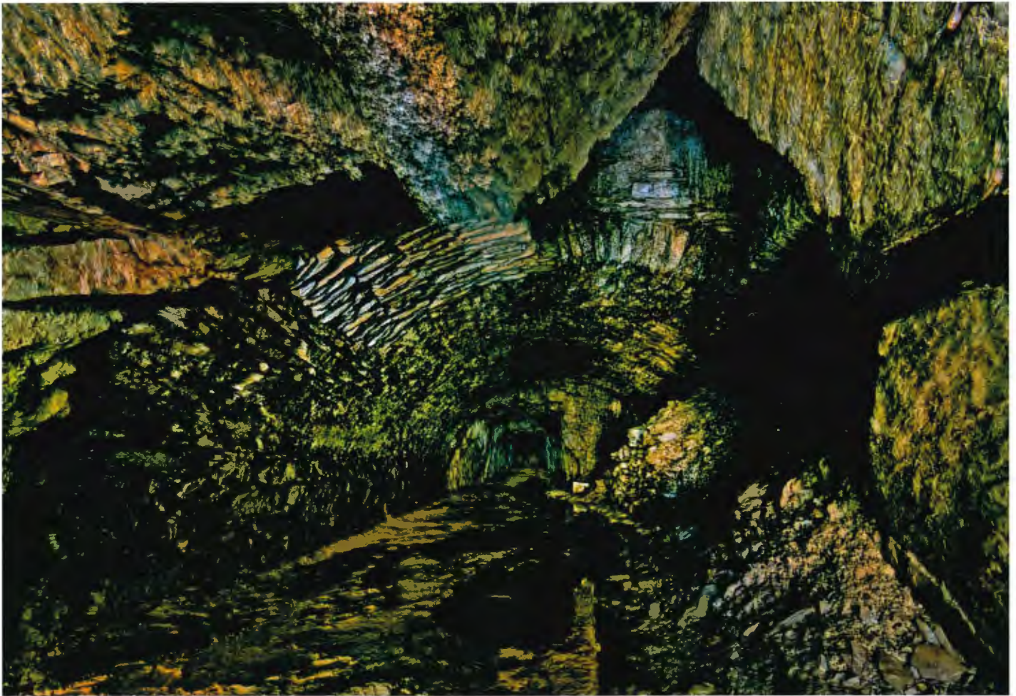
Abb. 10: Die Maschinenkammer der Wassersäulenmaschine der Grube Guldenhardt bei Herdorf. Die Maschinenkammer ist bis zur Stollensohle verfüllt. Man erkennt das aus Bruchsteinen gemauerte Gewölbe. Rechts oben erkennt man den aufgehenden Schacht, durch den das Einfallrohr verlief.
