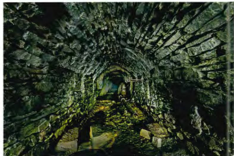
Abb. 11: Blick in den Tiefen Stollen der Grube Guldenhardt bei Herdorf
