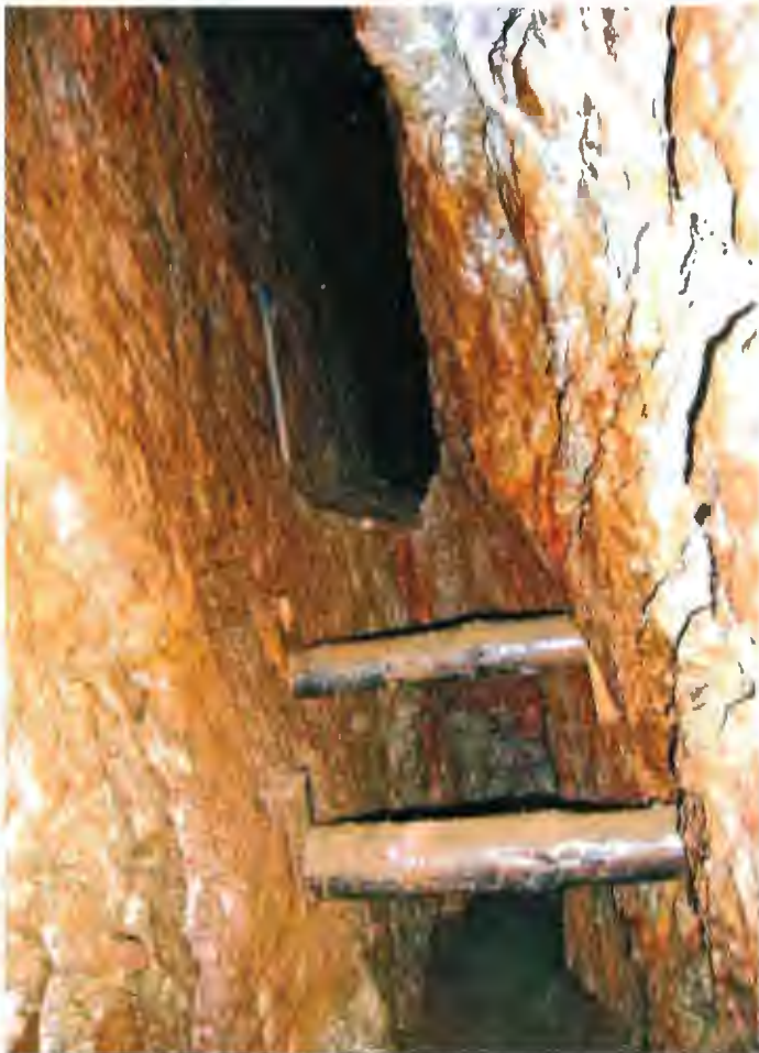
Abb. 5. Dippoldiswalde, Schacht Nr. 5, Gangabbau nach Nordost (hölzerne Spreizen modern eingefügt)
