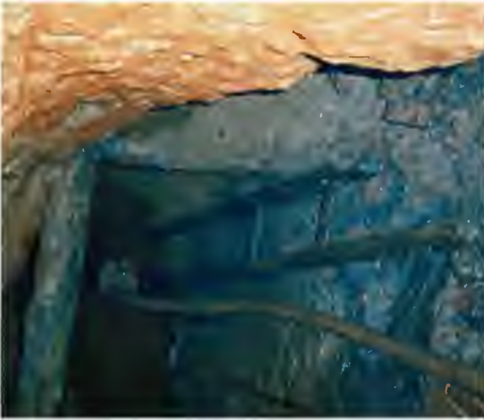
Abb. 22: Dippoldiswalde, Untersuchungsschacht 7, B 170/Pension Göhler; eine weitere mittelalterliche Fahrt (1224 [d]) befand sich ebenfalls noch in situ in einem Blindschacht. Dessen Rahmen wird durch zwei runde Spreizhölzer gebildet, die in Bühnlöcher der Schachtstöße lagern
