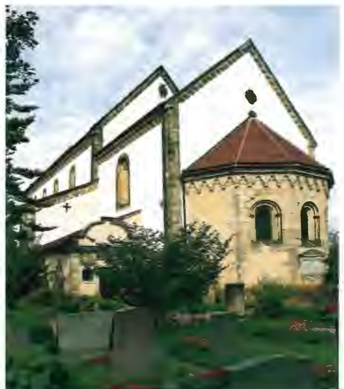
Abb. 3. Dippoldiswalde, Nikolaikirche, Ansicht der Ostteile von Südost
