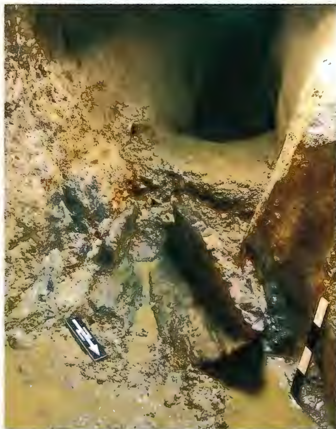
Abb. 19: Dippoldiswalde, nordöstlicher Anfang der Wasserhaltung: Zwei winkelförmige Hölzer leiten das Wasser aus der trichterförmigen Erweiterung in den Rinneneinlauf, von Nordost
