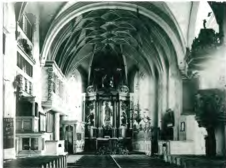
Hettstedt, St. Jakobi-Kirche (vor der Restaurierung im Jahre 1905). Im Chor links und rechts die heute verschwundenen Logen
