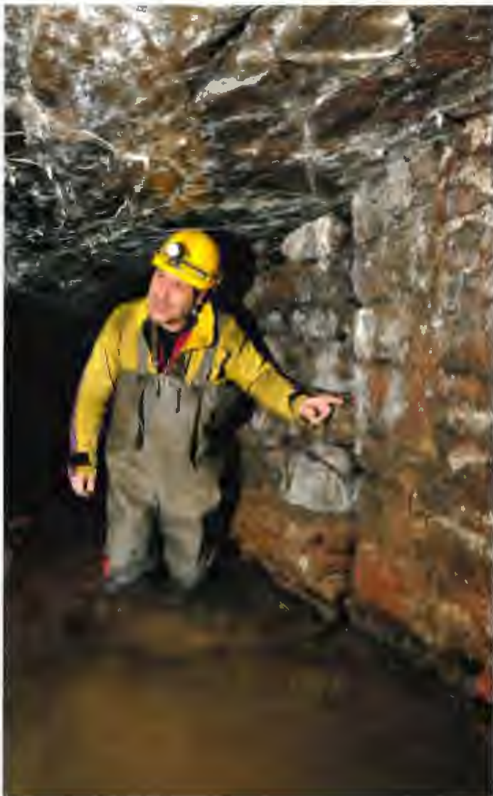
Abb. 19: Gut erkennbar sind im Bereich des Froschmühlenstollens die Trennmauern der Schachttrümmern des Flachen Kunstschachtes (2011)
