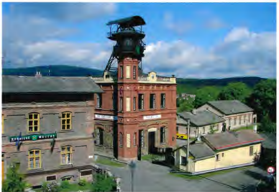
Abb. 5: Kaiser-Franz-Josef I Schachtanlage (heute Ševčín-Schacht) auf der Beer als Hauptidegenieur tätig war
