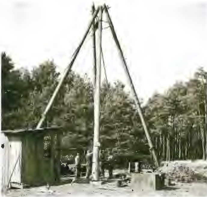
Abb. 13: Vierbock-Handbohrgerät 441 mit Maschinenbude; Dieselmotor für den Haspelantrieb zum Ein- und Ausbau der Bohrwerkzeuge und Verrohrung
