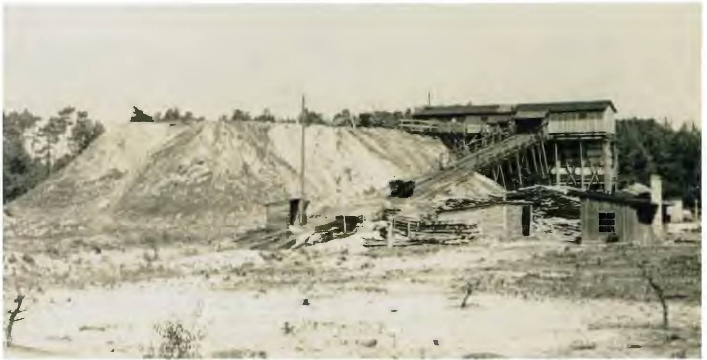
Abb. 11: Conow-Stollen IV; Kettenbahn, Kohlenbunker und Abraumhalde
