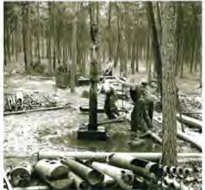
Abb. 14: Am Bohrergerät 441: Im Vordergrund diverse Bohrwerkzeuge wie Schappen und Spiralen für bindige Sedimente, Ventile bzw. Schlammbüchsen für rollige Sedimente sowie Bohrgestänge
