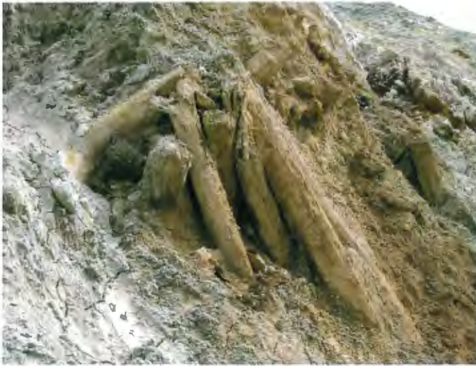
Reste einer wahrscheinlich songzeitlichen Grubenzimmerung ragen in einen modernen Kupfertagebau. Grube Qibaoshan 七寶山 bei Shaoguan 韶關, Provinz Guangdong
