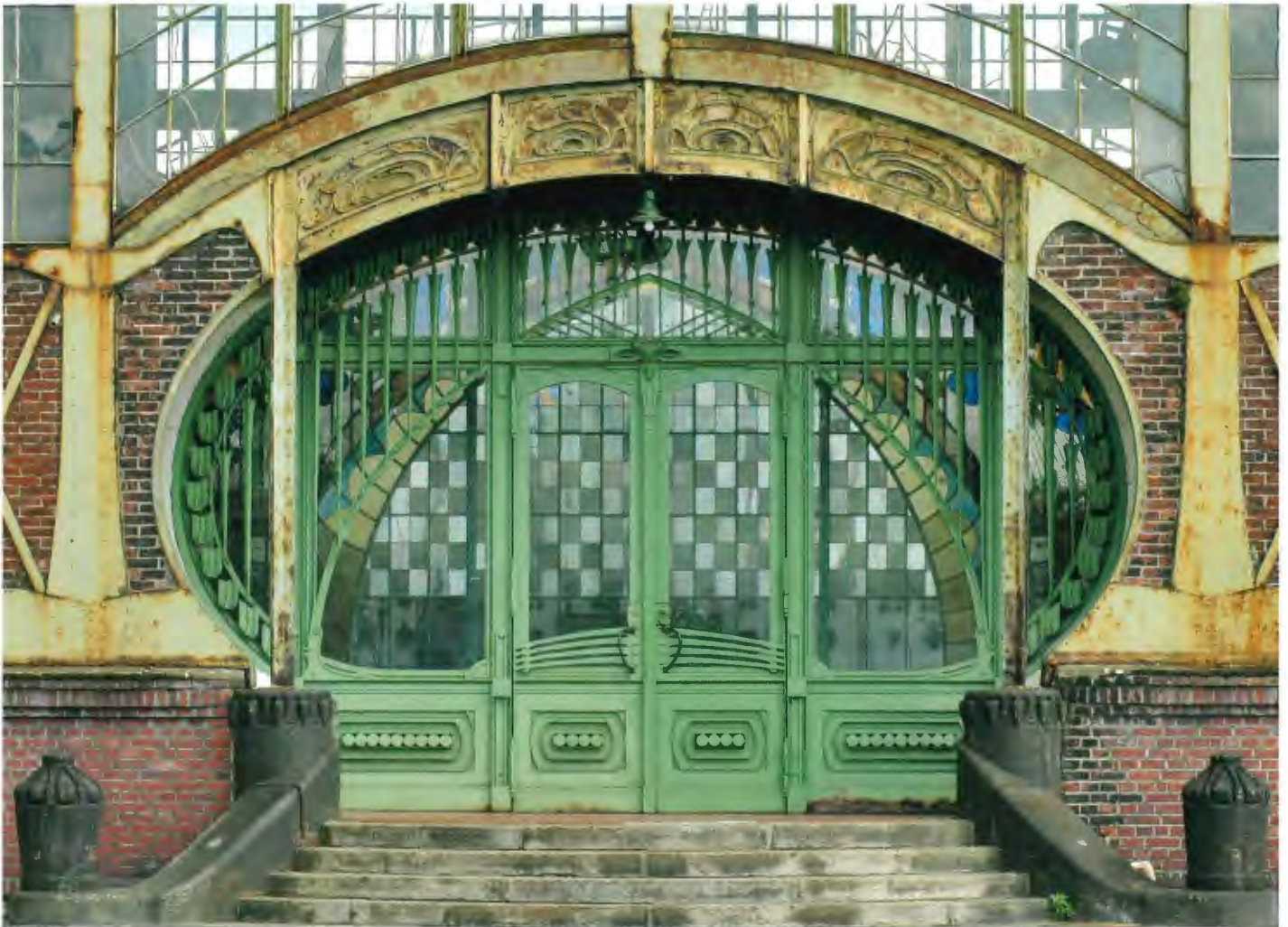
Abb. 3. Das Jugendstil-Portal der Halle gestaltete der Berliner Architekt Bruno Möhring, © LWL-Industriemuseum/Martin Holtappels
