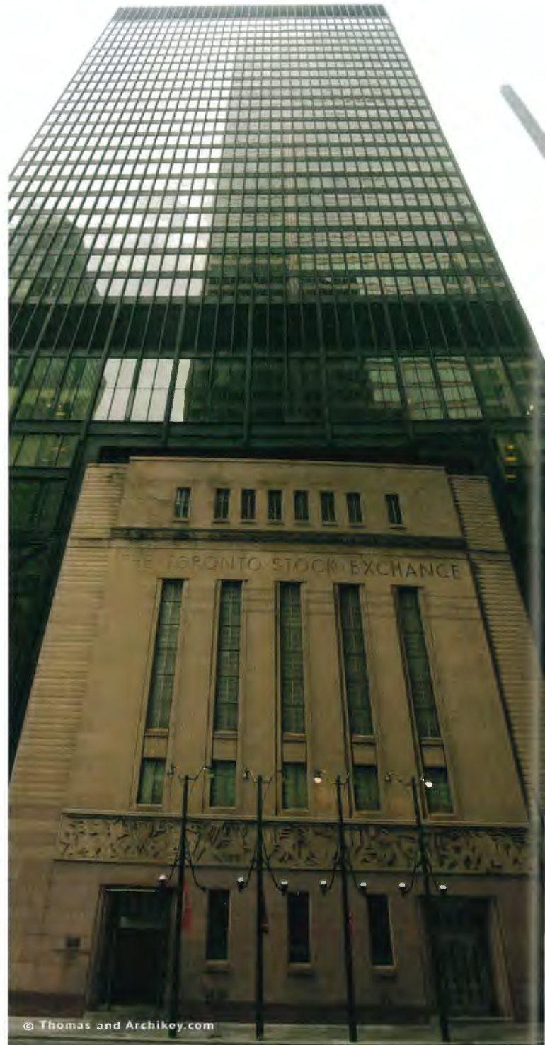
Das alte Gebäude der Toronto Stock Exchange in ein neues Gebäude integriert (2008). Die Toronto Stock Exchange ist die bedeutendste Börse in der Welt für Bergbauaktien
