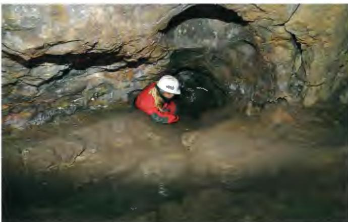
ten bestanden keine Zweifel bezüglich einer Zusammengehörigkeit des oberen und des tieferen Abschnitts des Alten Mannes. Zusammengenommen streicht der Abbau somit in NO-SW Richtung und fällt dem Streichen folgend nach SW ein. Der tiefere Abschnitt zeigt sich in Form einer kleinen Kammer von 3 m Länge und durchschnittlich 2 m Breite. Die Höhe beträgt im Mundlochbereich 1,20 m; verengt sich jedoch mit zunehmender Tiefe auf 0,50 m (Abb. 13).
