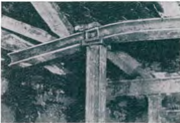
Abb. 7: Verdrehte Stahlkappe (Spruth 1948, S. 131, Abb. 90)
