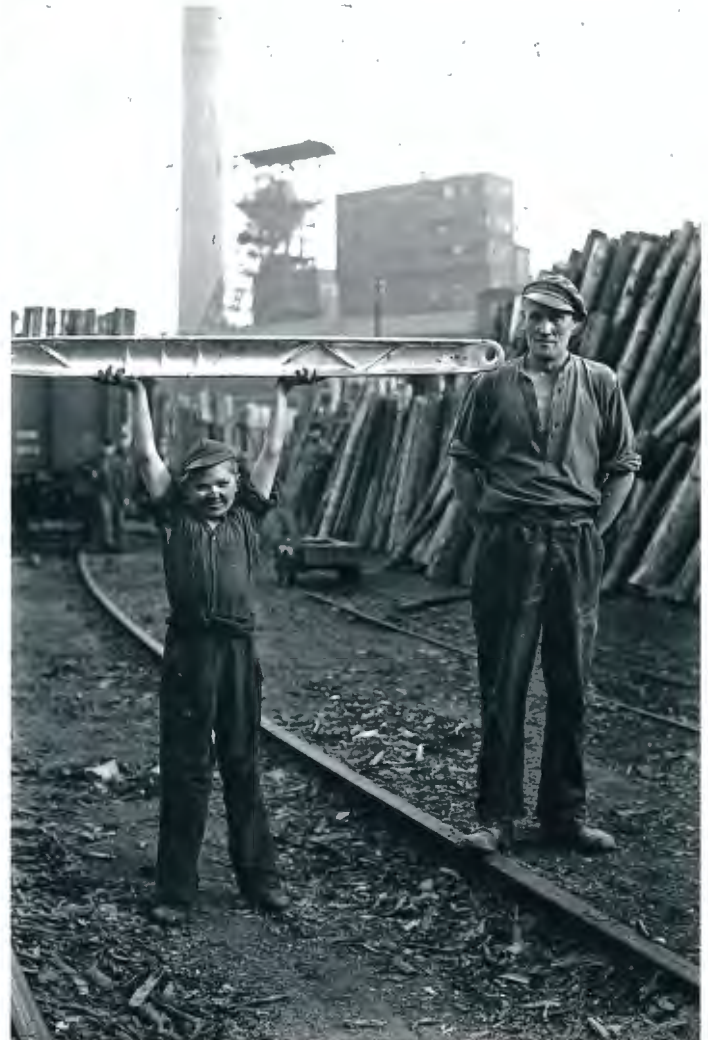
Abb. 9: TZG-Kappe aus Aluminium
