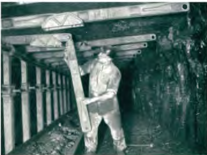
Abb. 8: Strebaubau mit Treibzapfengelenkkappe der GHH (Fritzsche 1962, S. 576, Abb. 504)
