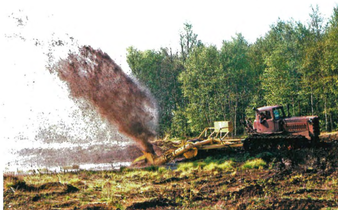
Abb. 6a: Grabenentwässerung im Weitendorfer Moor mittels sowjetischer Grabenentwässerungsmaschine Typ RK-OA i. J. 1983
