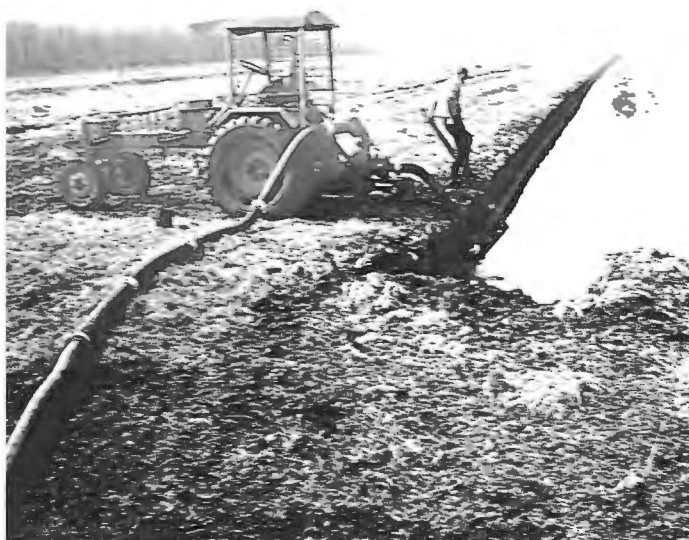
Abb. 6b: Grabenentwässerung im Weitendorfer Moor mittels Kreiselpumpe, angetrieben von der Zapfwelle des Traktors (1970er-Jahre)
