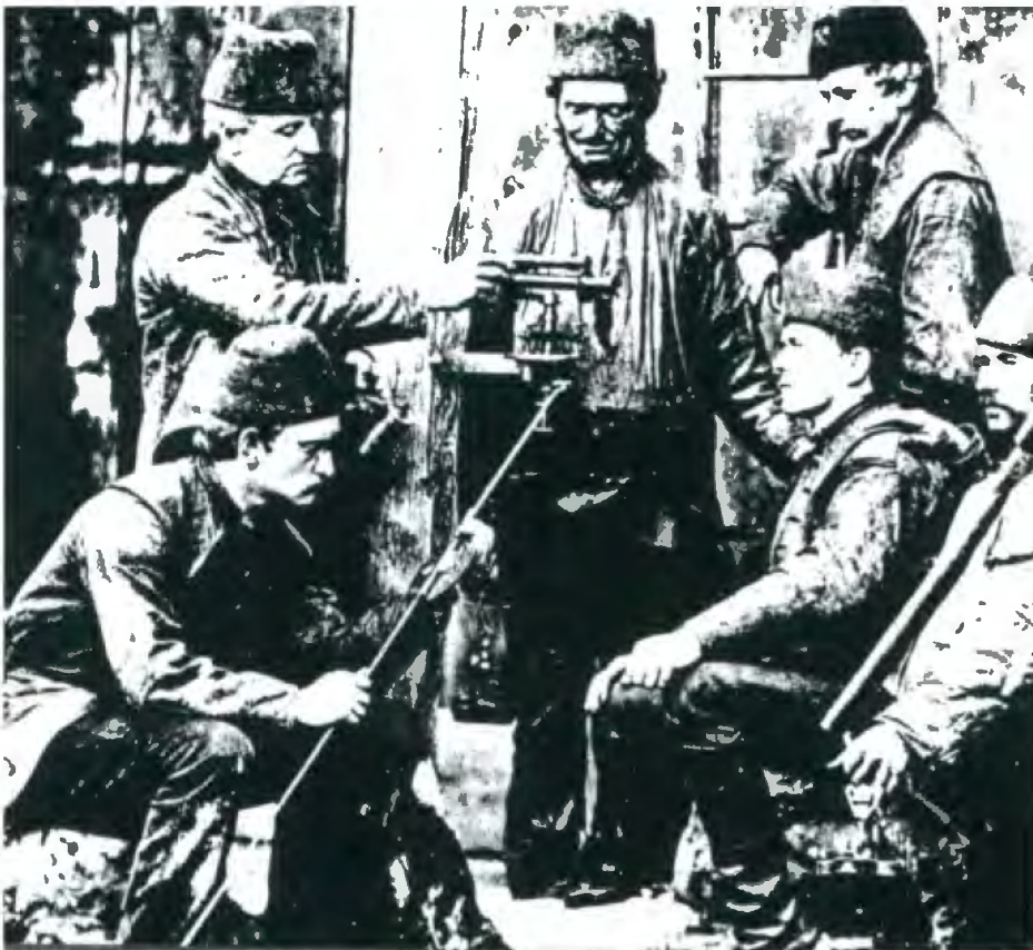
Eduard Borchers mit Mitarbeitern und Studenten beim Gruben-Nivellement
