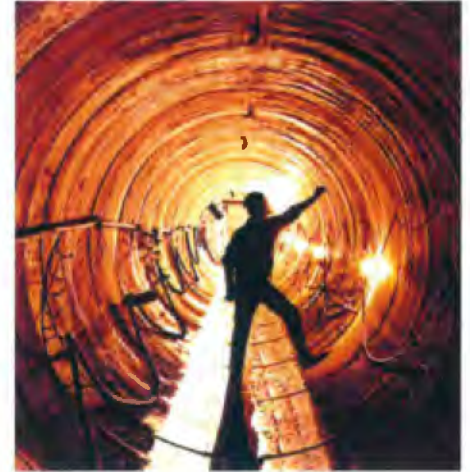
Unterquerung der Havel mit einem 110 m langen Schutzstunnel (Rohbau) für die Fernwärmeversorgung in Berlin
