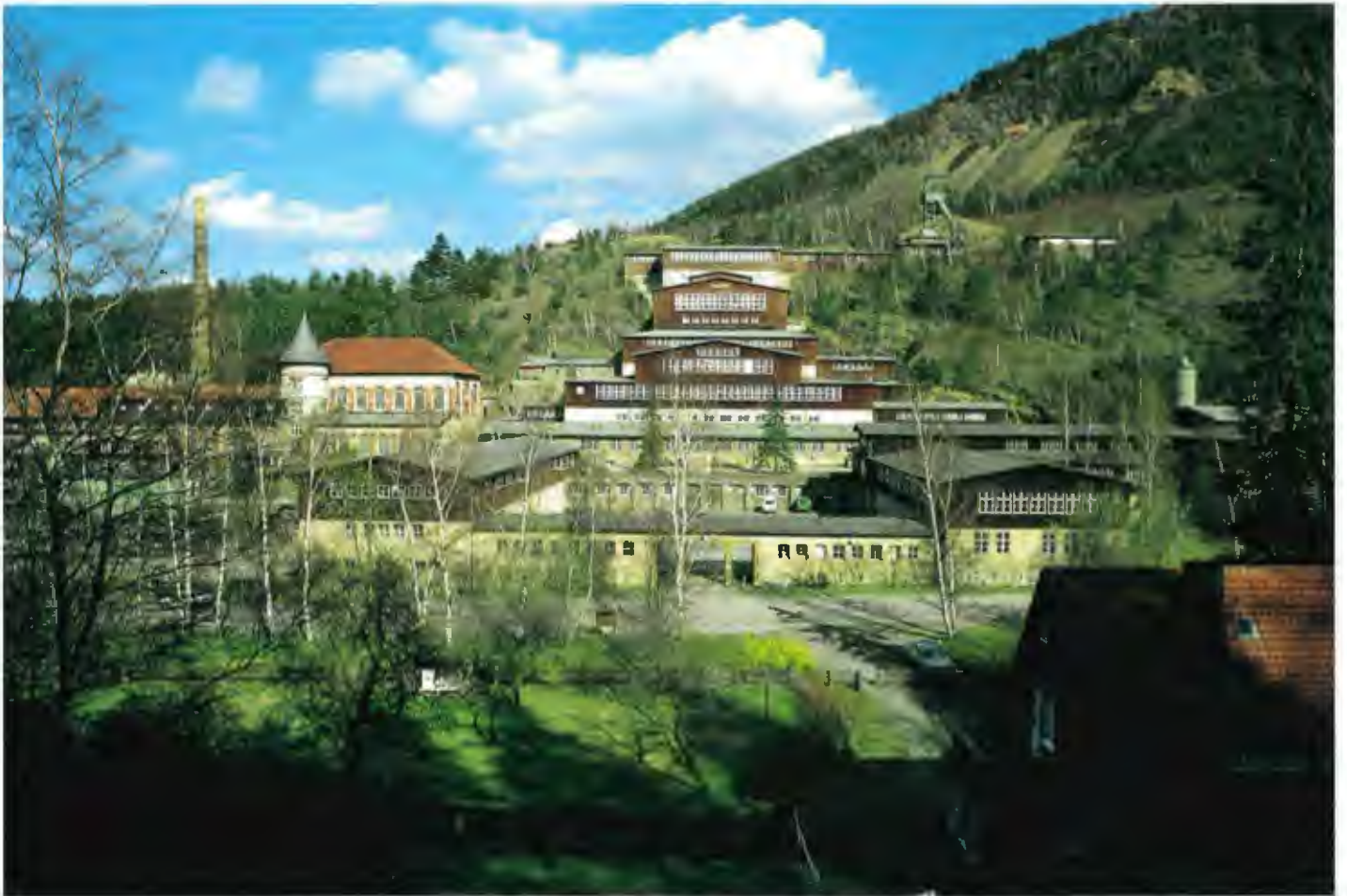
Abb. 3: Die Aufbereitungsanlage des Erzbergwerks Rammelsberg am Berghang (Bildmitte), darüber Fördergerüst und Schachthalle, vor der Aufbereitung der Betriebshof umgeben von Verwaltungsgebäuden. Die Anlage in ihrer heutigen Form entstand im Zug des „Rammelsbergprojekts“ im Rahmen der nationalsozialistischen Industrieförderung 1937 bis 1939
