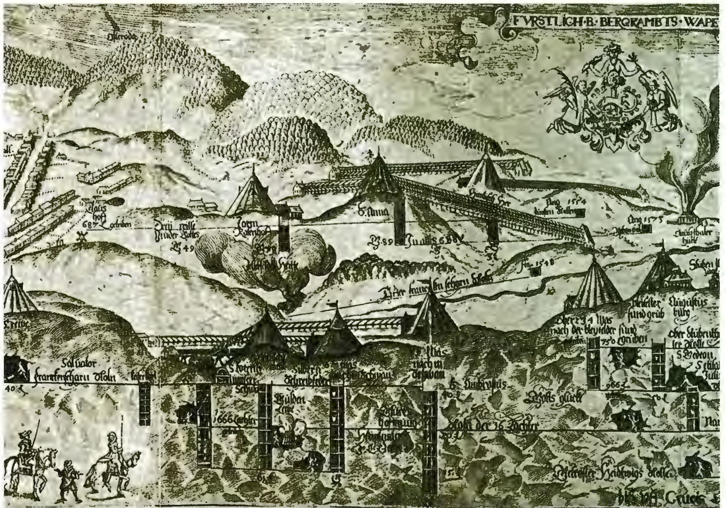
Abb. 8: Erzbergwerke und Göpelwerke zur Förderung, Kunstgestänge der Wasserkraft-Anlagen zur Kraftübertragung zu den Schächten und schematisch angedeuteten Hauptstollen bei Clausthal-Zellerfeld im Harz; oben in der Mitte das Göpelgebäude über dem Schacht St. Anna bei Clausthal mit mehreren dort hingeführten Kunstgestängen (Ausschnitt, Zacharias Koch und Daniel Lindemair 1606)
