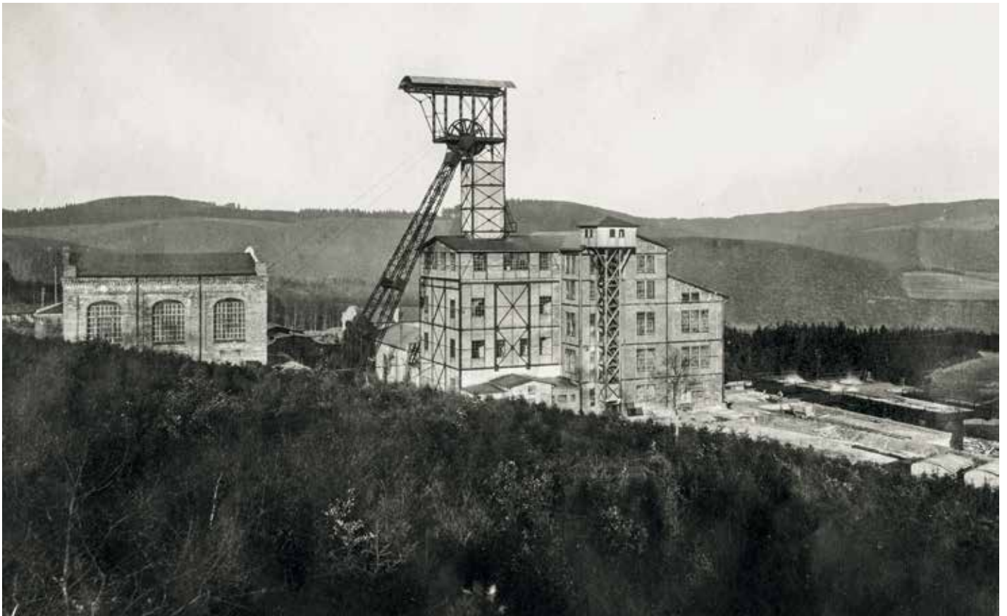
Abb. 10: Der Blick von Süd-West auf dieselbe Anlage kurz vor ihrem Ende (Foto um 1930). Die auf der rechten Seite der Schachthalle angebaute Rohspataufbereitung bildete schon aus statischen Gründen mit ihrer schweren maschinellen Ausstattung einen eigenständigen Baukörper. Sie wurde bereits 1936 abgetragen und auf der Grube Lohmannsfeld/Große Burg in Altenseelbach mit dem gesamten Maschinenpark und Röstöfen wieder aufgestellt. (Archiv der Barbara Rohstoffbetriebe GmbH, Langenfeld)
