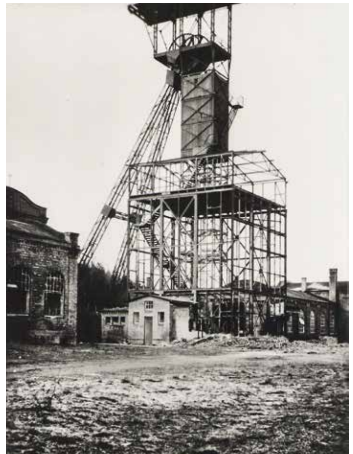
Abb.11: 1938 werden der Förderturm sowie die in Stahlfachwerk mit Ziegelsteinausmauerung errichtete Schachthalle des Neuen Schachtes des Stahlbergs in Müsen abgebaut. (© Foto: Paula Nockemann)
