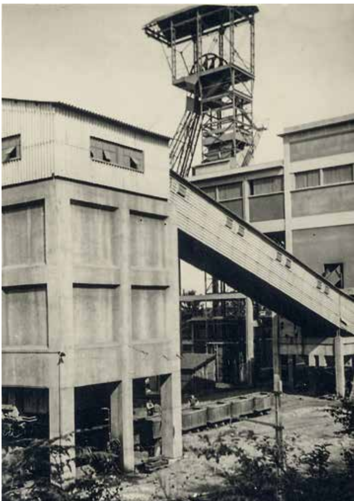
Abb. 5 oben: Ein Blick aus der Vogelperspektive auf die Eisenerzgrube Saint-Clair-de-Halouze in ihrer letzten Betriebsperiode bis 1978. Das Fördergerüst trägt noch die heute abgerostete giebelartige Überdachung, um die es nach der Montage in Frankreich ergänzt worden ist. Im Vordergrund das heute leerstehende Fördermaschinenhaus nebst Elektrozentrale. Links davon das ehemalige Kauen- und Bürogebäude. (Archiv des Museums Maison du Fer, Dompierre, Frankreich)
