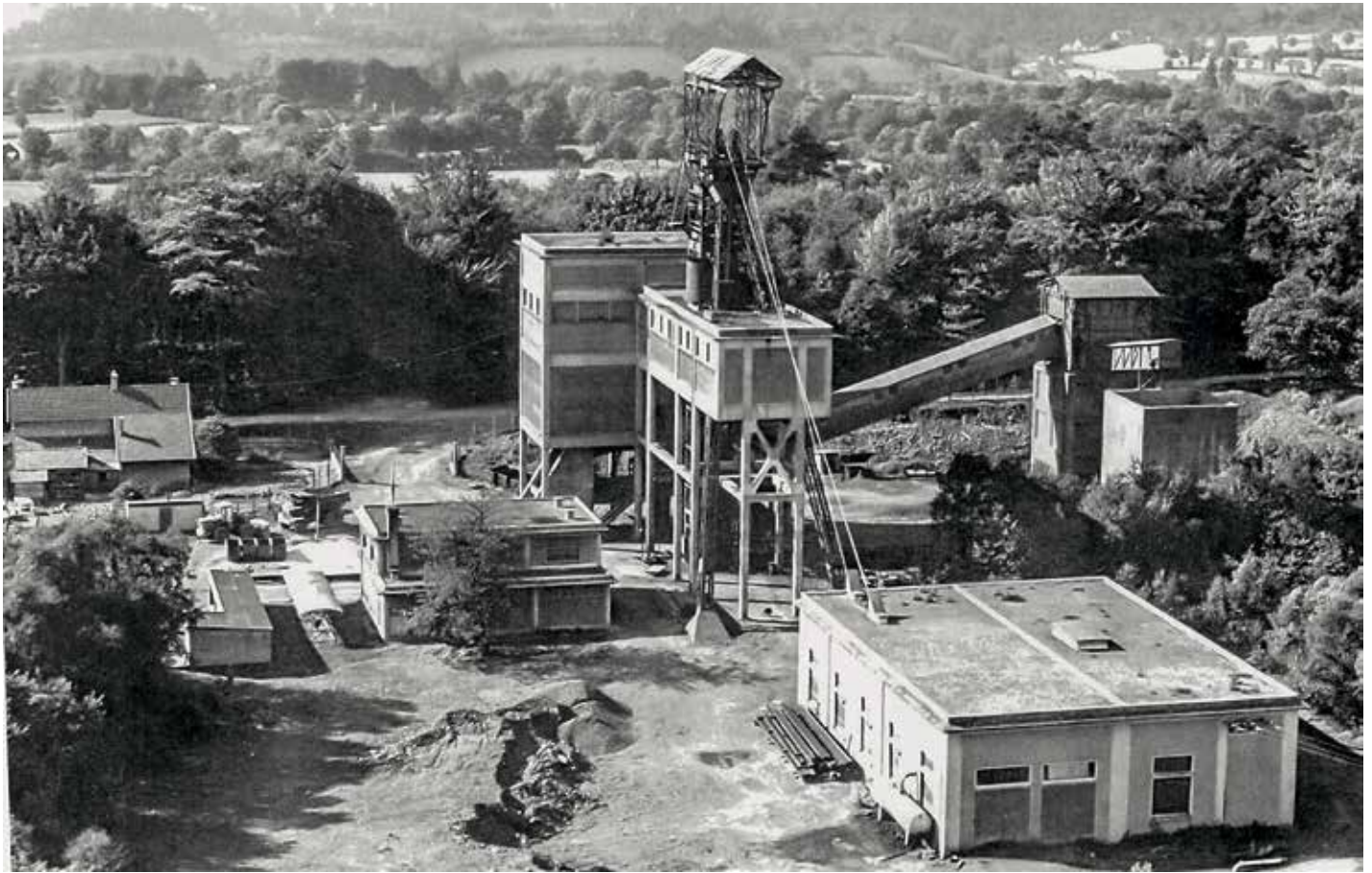
Abb. 5 oben: Ein Blick aus der Vogelperspektive auf die Eisenerzgrube Saint-Clair-de-Halouze in ihrer letzten Betriebsperiode bis 1978. Das Fördergerüst trägt noch die heute abgerostete giebelartige Überdachung, um die es nach der Montage in Frankreich ergänzt worden ist. Im Vordergrund das heute leerstehende Fördermaschinenhaus nebst Elektrozentrale. Links davon das ehemalige Kauen- und Bürogebäude. (Archiv des Museums Maison du Fer, Dompierre, Frankreich)
