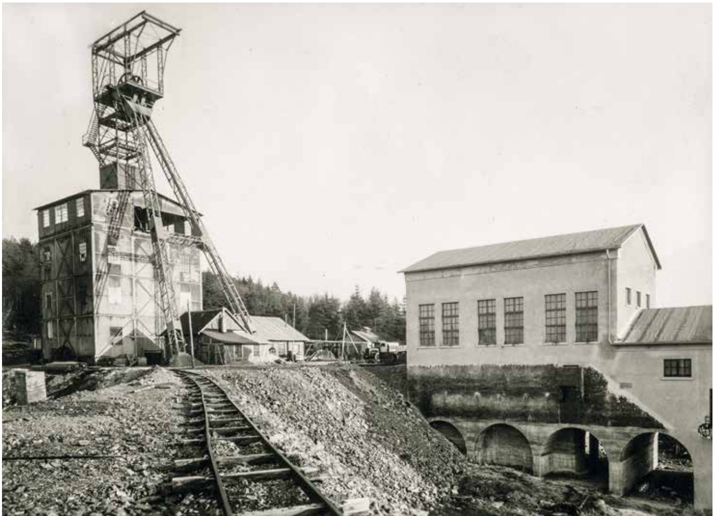
Abb. 7: Die damals noch im Aufbau befindliche Schachanlage Huth bei Hamm an der Sieg im Winterhalbjahr 1938/39. Das Fördergerüst scheint bereits frisch gestrichen zu sein, das Förderseil ist noch nicht aufgelegt worden. (Archiv der Barbara Rohstoffbetriebe GmbH, Langenfeld)
