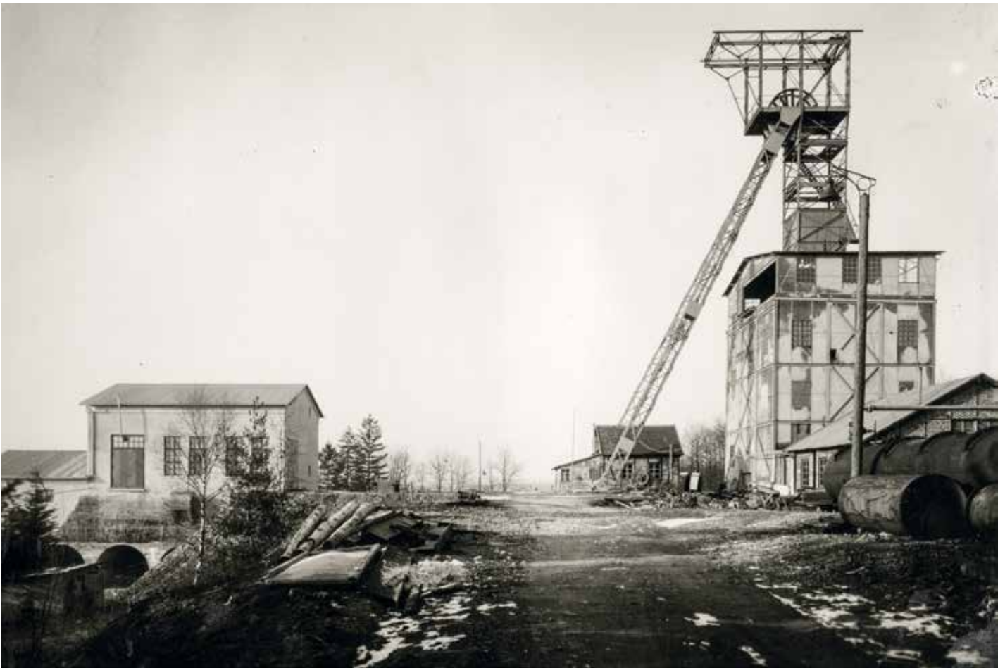
Abb.13: Fördergerüst 1938 bis 1948 auf der Grube Huth an der mittleren Sieg. (Archiv der Barbara Rohstoffbetriebe GmbH, Langenfeld)
