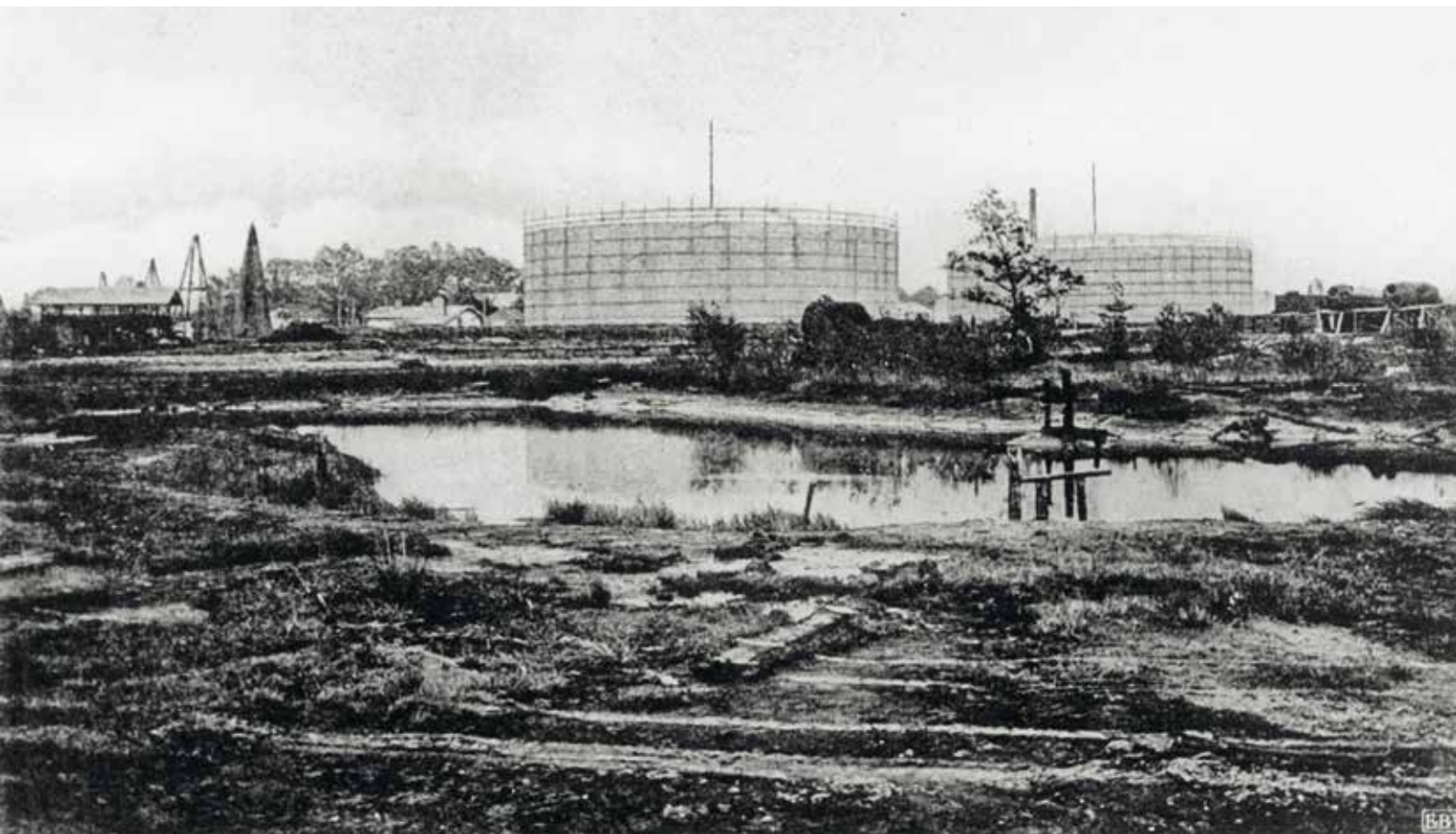
Abb. 2: Wallmannsche Teerkuhle im Jahre 1910. Am hinteren Ufer erkennt man die Sonde der Hunäus'schen Bohrung 1858/59 (Quelle: Archiv DEW).
