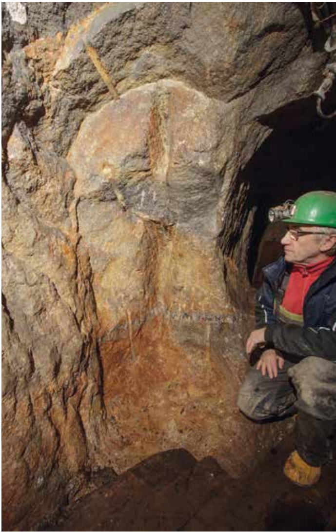
Abb. 3: Vortriebsort von etwa 1745 mit Schlägel- und Eisearbeit für den Einbruch sowie nachfolgender Bohr- und Sprengarbeit für den Streckenquerschnitt. Grube Zinnwald, Tiefer Bünau Stolln, Biermaullflügel. Bezug zur Beschreibung in Adolph Beyers Otia metallica , 1758, Teil 3 S. 110-112. (© Jens Kugler)
