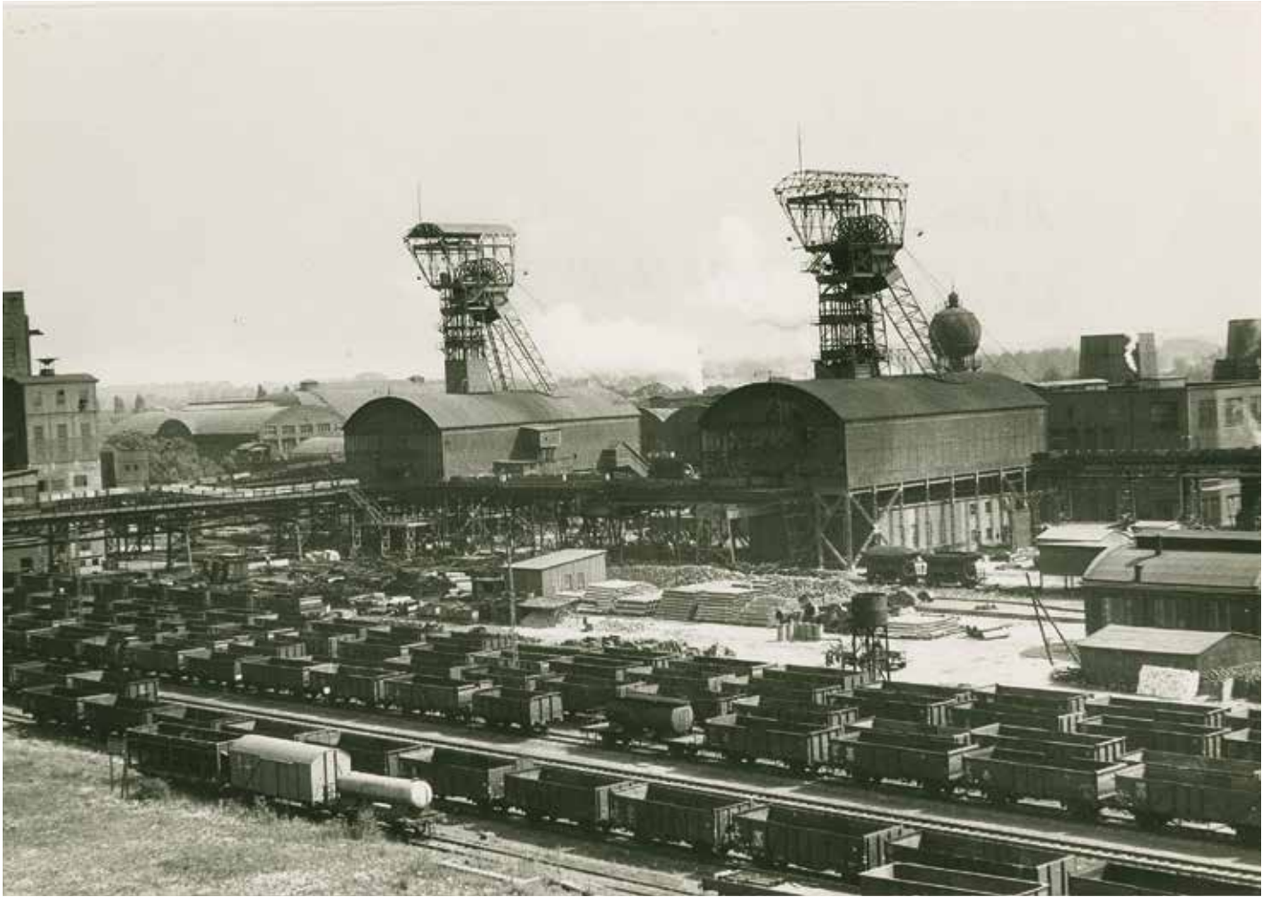
Abb. 10: Tagesanlagen der Zeche Westfalen in Ansicht von West nach Ost mit Fördergerüsten, Schachthallen und Wagenumlaufbrücken, dahinter weitere Betriebsgebäude, im Vordergrund Zechenbahn und Materiallager, ca. 1930er Jahre. (© montan.dok 024901073010)
